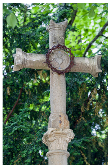
Détail de la croix. Phot. Sonia Dourlot IVR43_20157000287NUC2A
