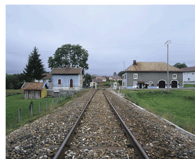
Vue d'ensemble depuis la voie, au sud. Phot. Yves Sancey IVR43_20043900233XA
