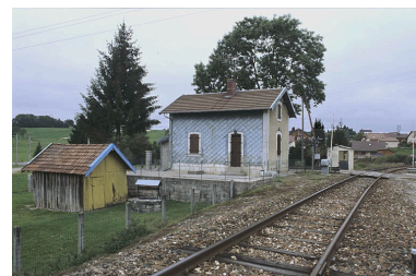
Elévations antérieure et latérale gauche. Phot. Yves Sancey IVR43_20043900238ZA
