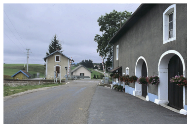
Vue d'ensemble, depuis l'est. Phot. Yves Sancey IVR43_20043900236ZA
