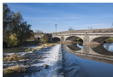
Vue générale depuis l'aval avec le barrage. Phot. Jérôme Mongreville IVR43_20127000584NUC4A
