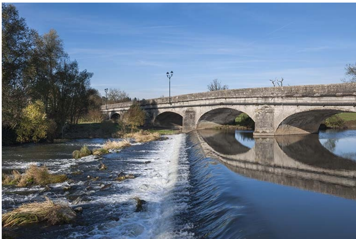
Vue générale depuis l'aval avec le barrage.
