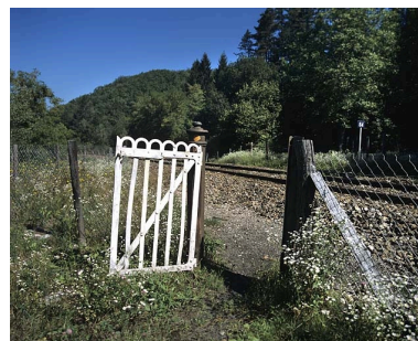
Portillon pour piétons, côté gauche de la voie. Phot. Yves Sancey IVR43_20050100025XA
