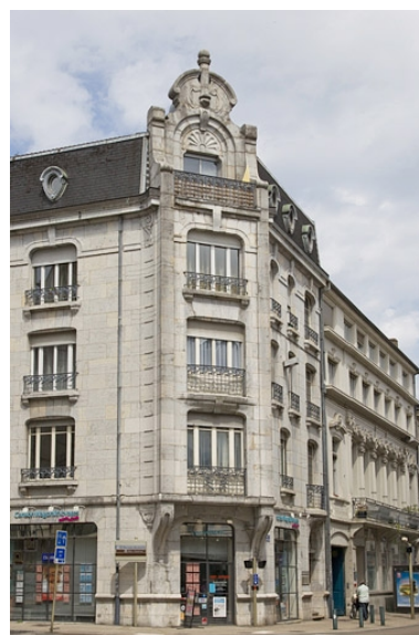
Vue d'ensemble rapprochée.
