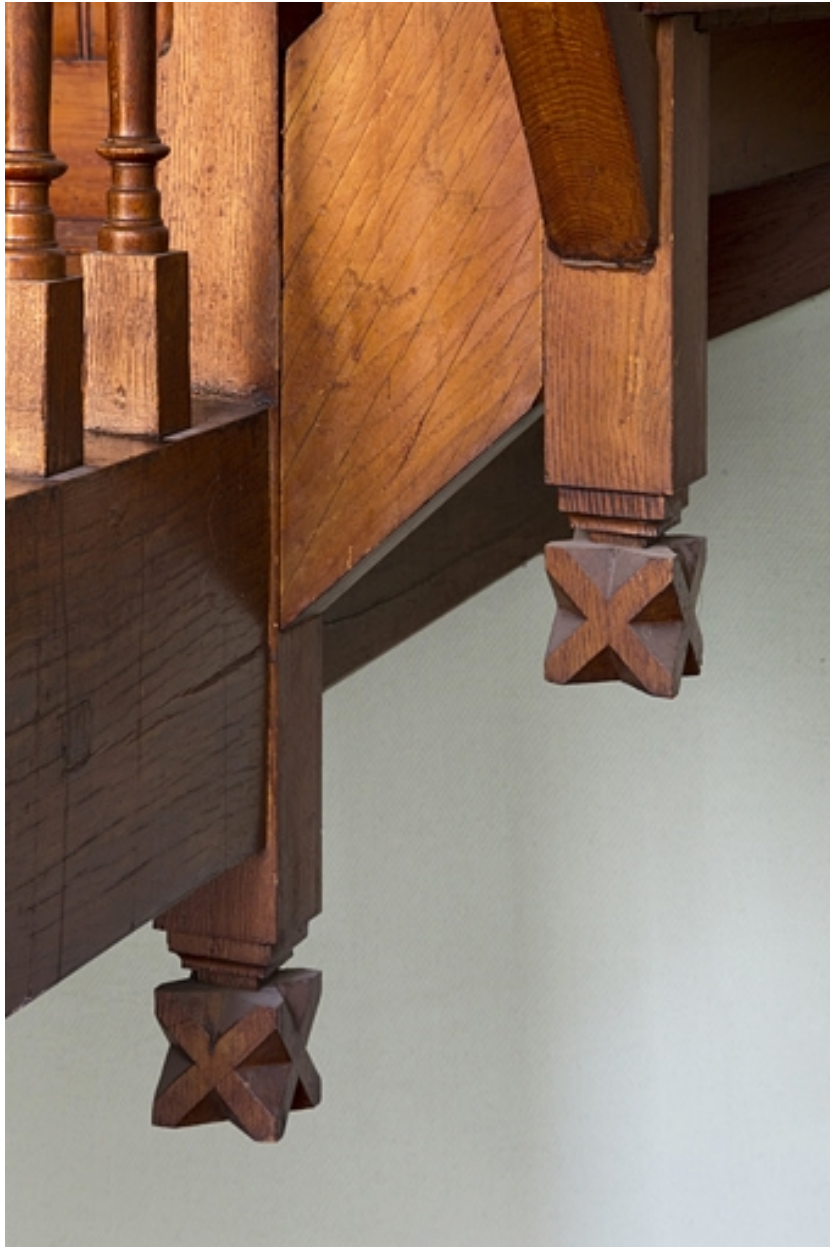
Intérieur, escalier : détail de la menuiserie.
