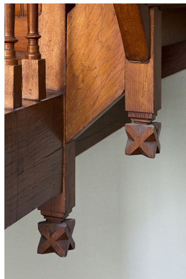
Intérieur, escalier : détail de la menuiserie.
