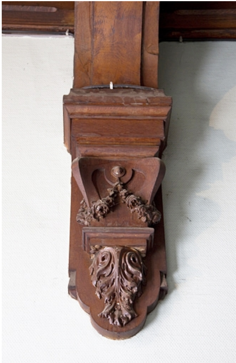
Intérieur, escalier : détail d'une console.
