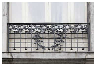
Détail du balcon d'angle du premier étage.
