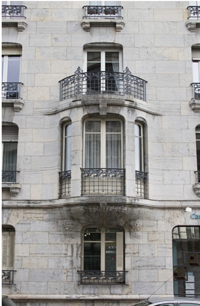
Façade latérale gauche : détail du bow-window.
