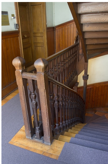
Intérieur, escalier : vue d'ensemble.
