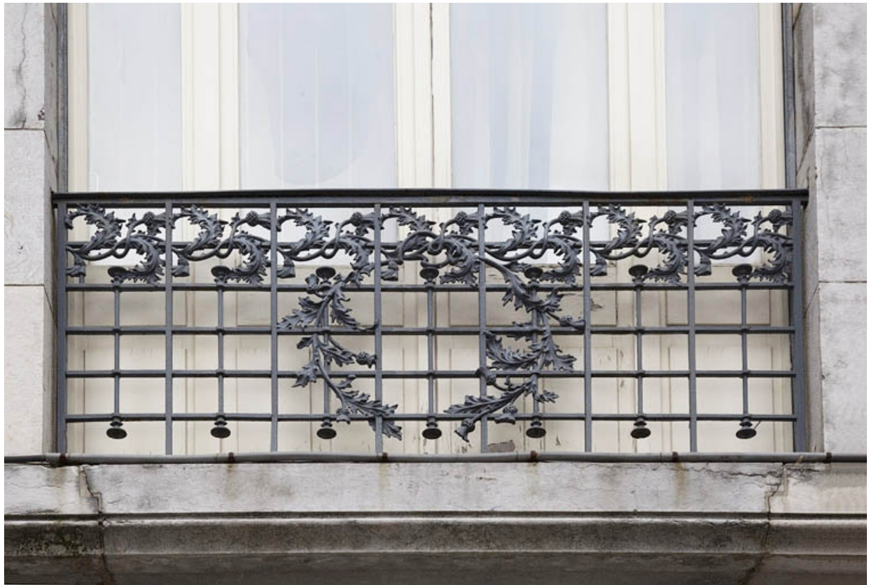
Détail du balcon d'angle du premier étage.
