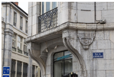
Façade d'angle : détail du rez-de-chaussée.
