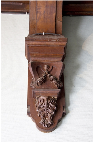
Intérieur, escalier : détail d'une console.
