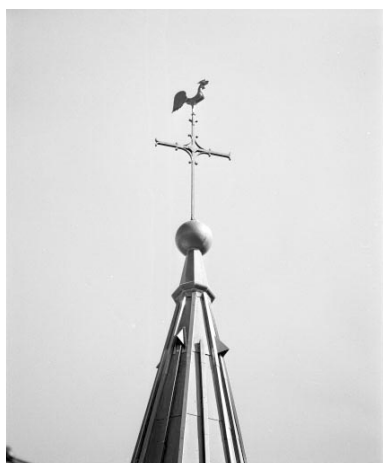
Extérieur : le sommet de la flèche. Phot. Yves Sancey IVR43_19943900987X
