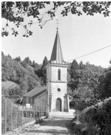
Extérieur : façade occidentale, vue de trois quarts. Phot. Yves Sancey IVR43_19943900986X
