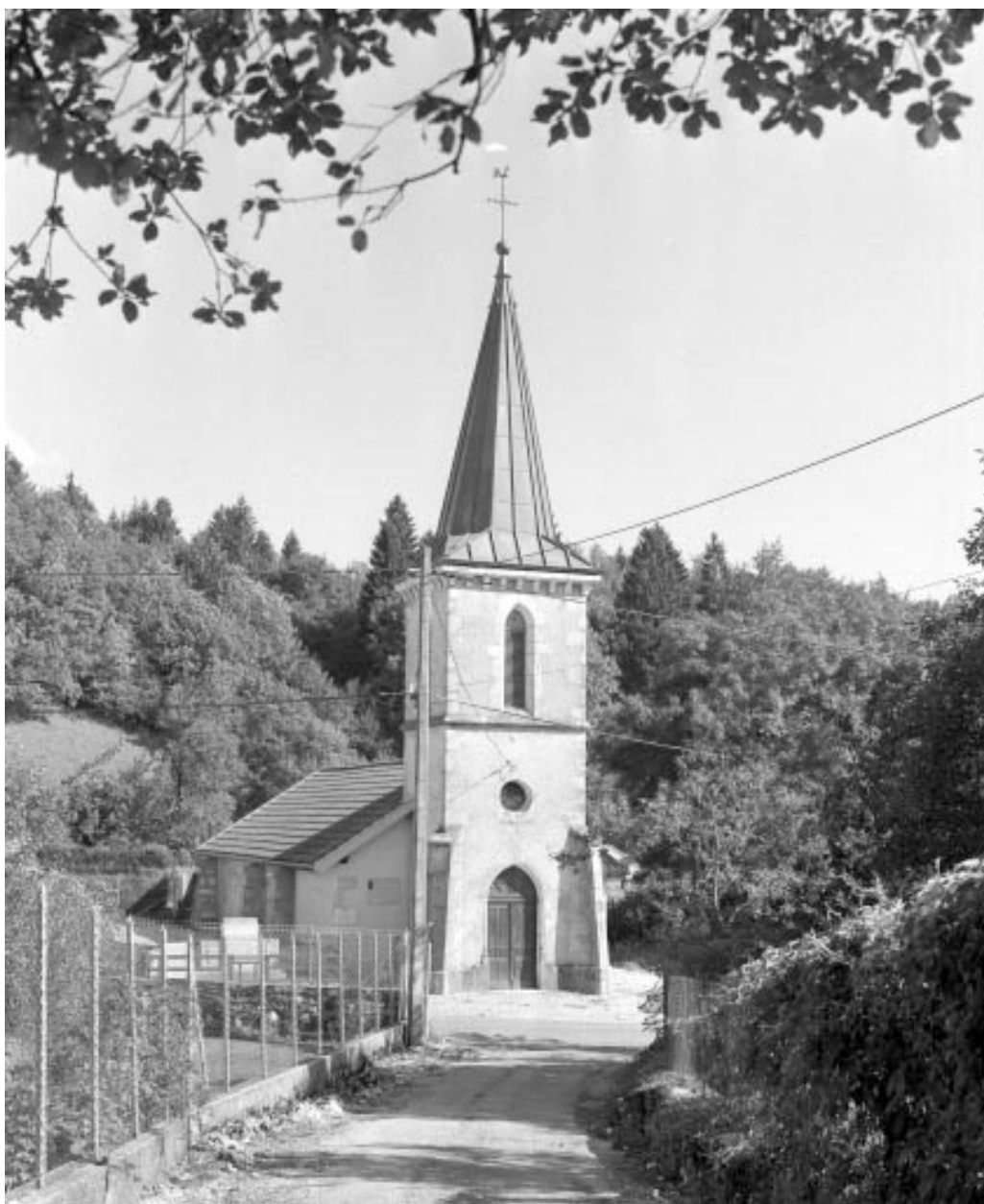
Extérieur : façade occidentale, vue de trois quarts.
