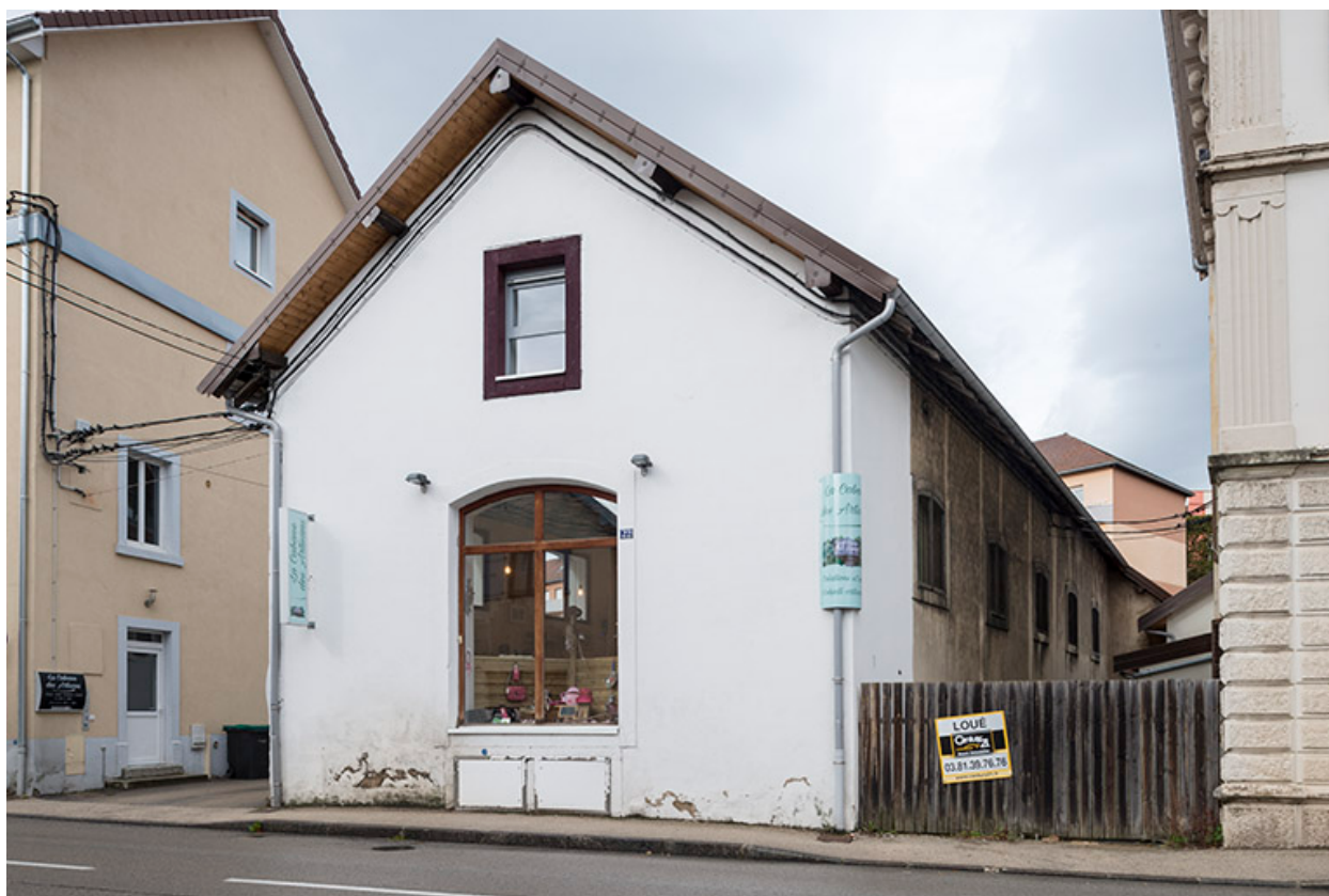
Pignon et façade nord.
