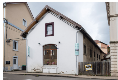
Pignon et façade nord. Phot. Jérôme Mongreville IVR43_20162501582NUC4A
