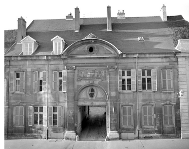
Façade antérieure de l'hôtel, vue de face. Phot. Yves Sancey IVR43_19893900585X
