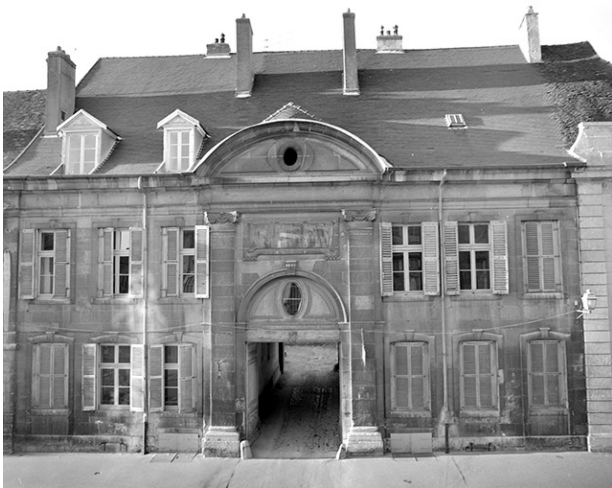
Façade antérieure de l'hôtel, vue de face.
