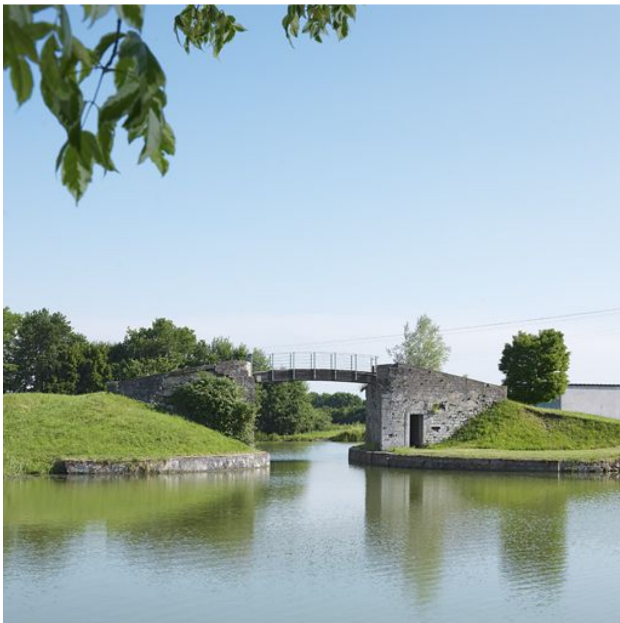
Vue de la passerelle haute, de face.
