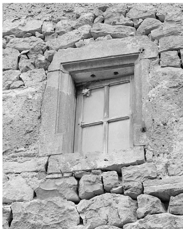
Détail d'une fenêtre sur la façade postérieure. Phot. Jérôme Mongreville IVR43_19963901002X
