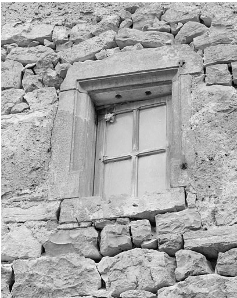
Détail d'une fenêtre sur la façade postérieure.
