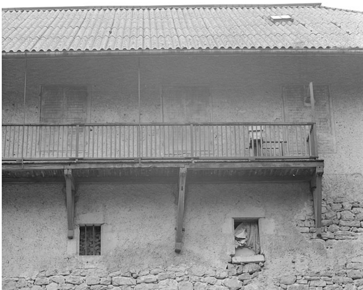
Détail de la façade postérieure.
