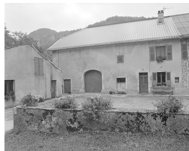
Façade antérieure de la ferme. Phot. Jérôme Mongreville IVR43_19963901000X
