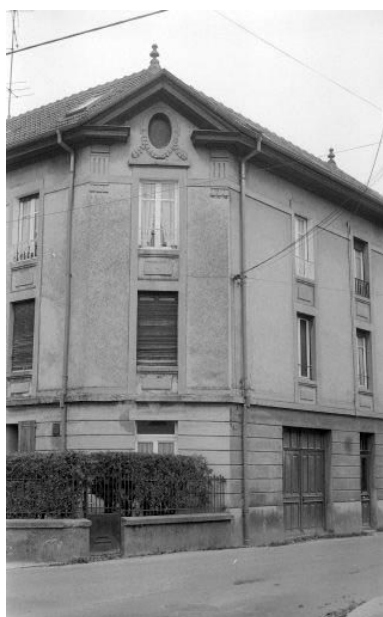
Immeuble situé 14 rue des Vergers. Phot. Bernard Lardière IVR43_19832500191Z
