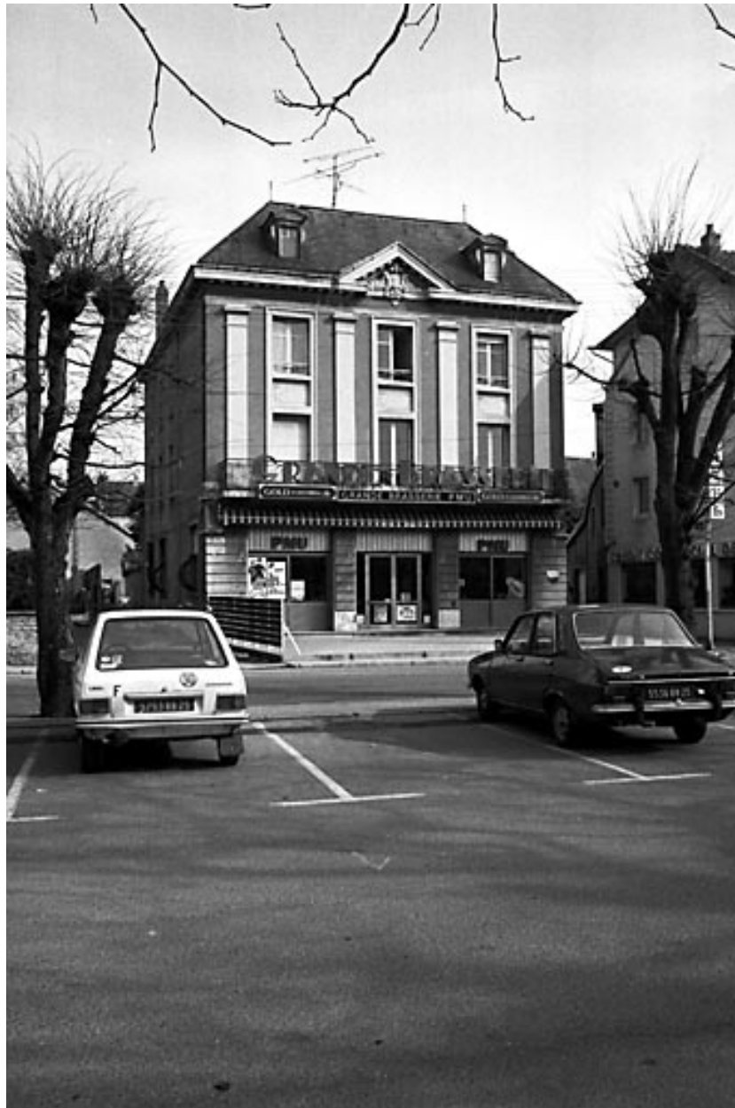
Immeuble situé 7 rue du Doubs.
