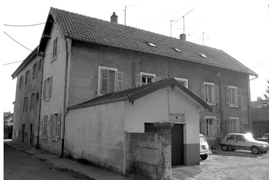
Immeuble situé 19 rue Neuve. Phot. Bernard Lardière IVR43_19832500189Z
