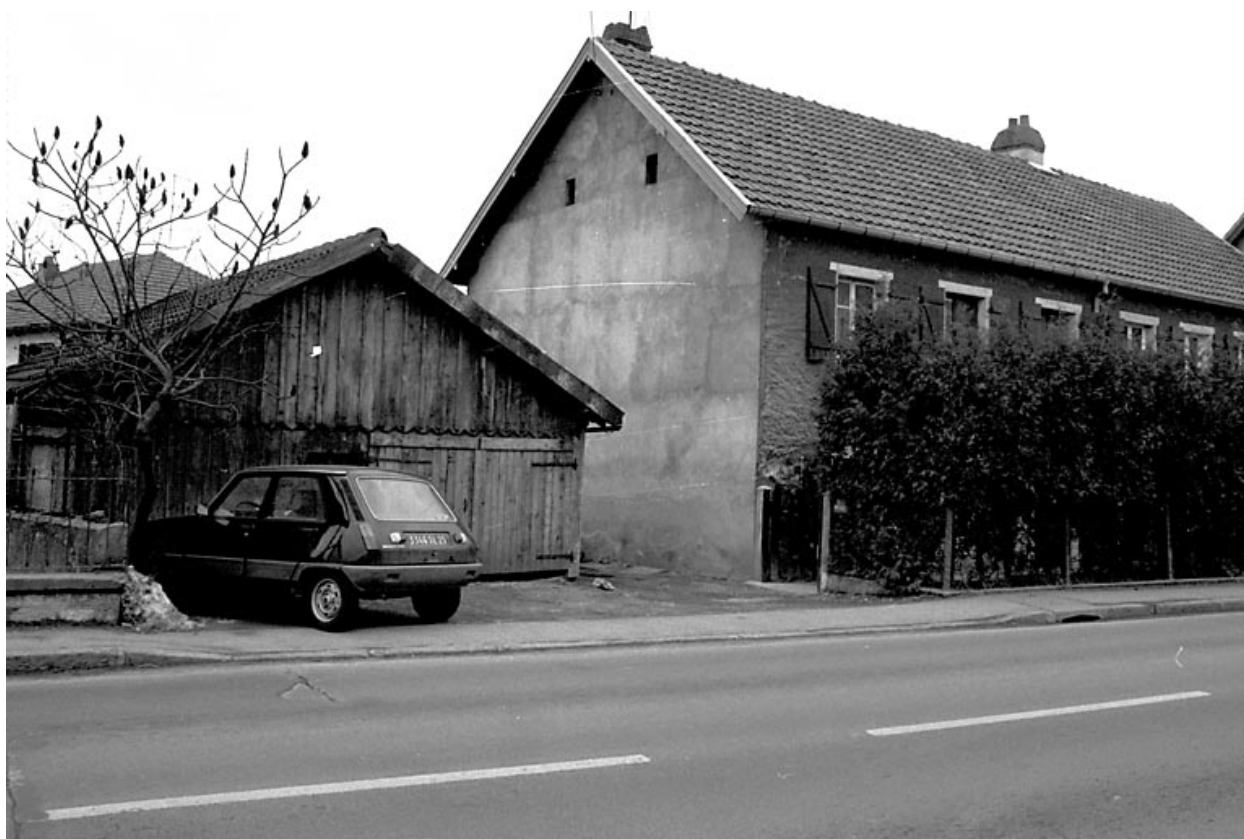
Immeuble situé 20 rue de Montbéliard.
