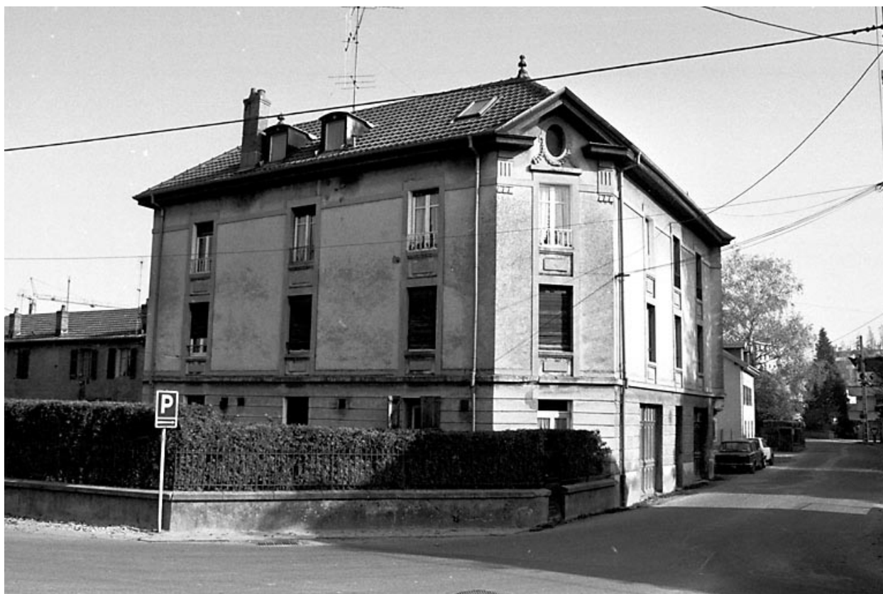
Immeuble situé 14 rue des Vergers.
