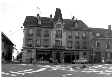
Immeuble situé 69 rue de Belfort. Phot. Bernard Lardière IVR43_19832500135Z
