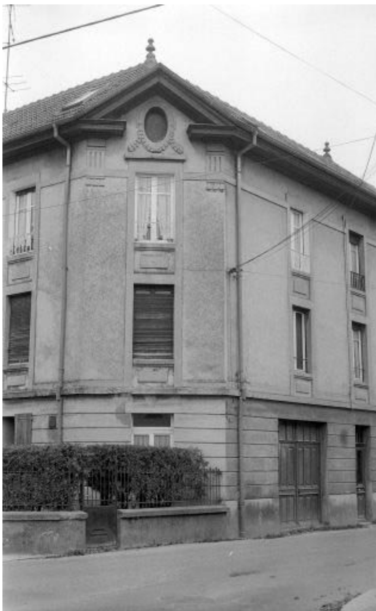
Immeuble situé 14 rue des Vergers.
