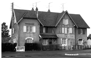
Immeuble situé 15 rue de Verdun. Phot. Bernard Lardière IVR43_19832500284Z
