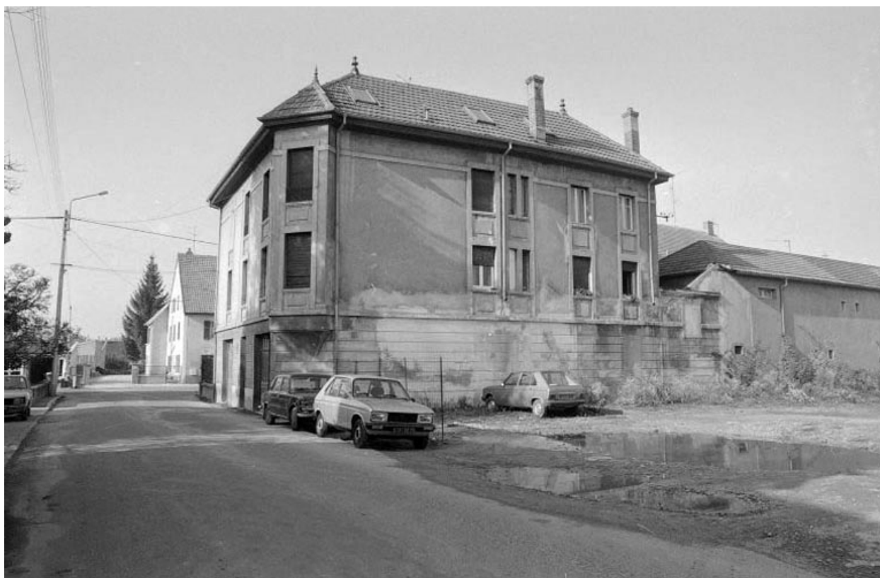
Immeuble situé 14 rue des Vergers.
