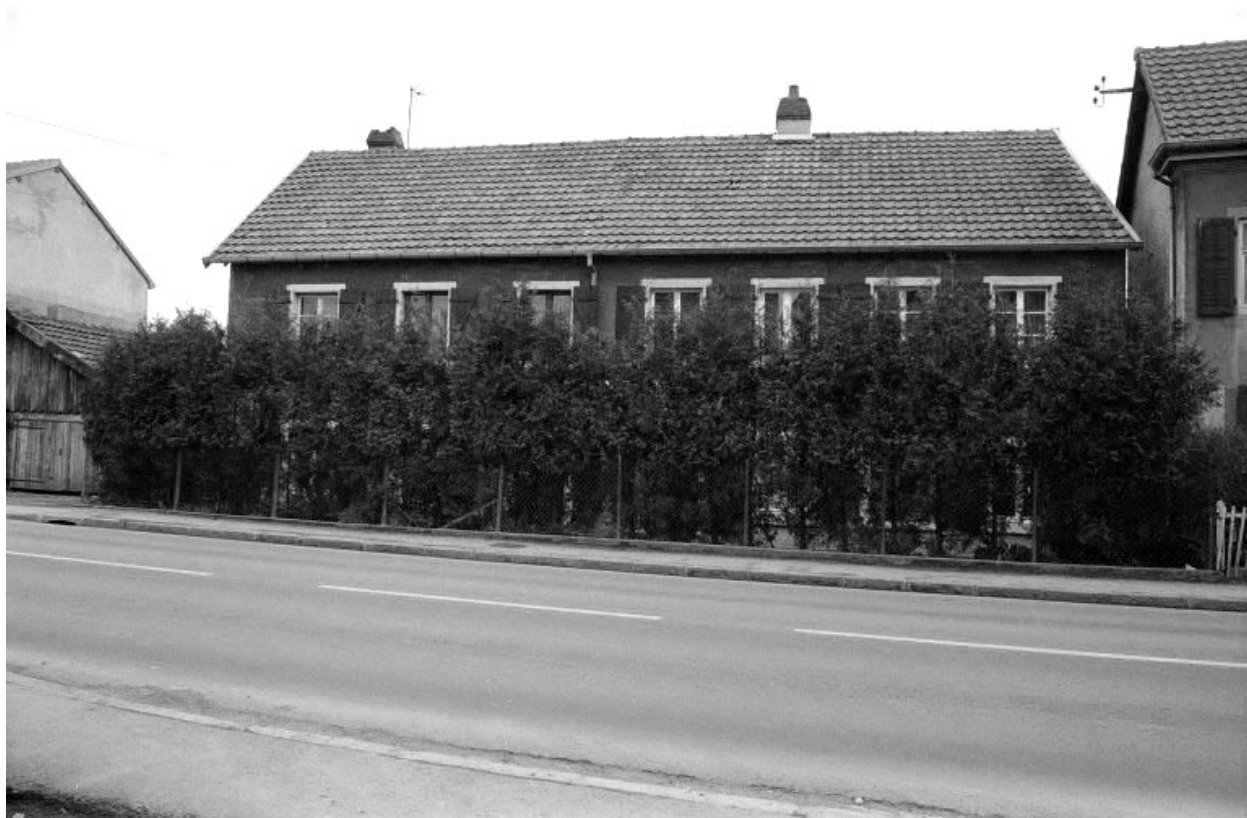
Immeuble situé 20 rue de Montbéliard.
