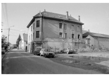
Immeuble situé 14 rue des Vergers. Phot. Bernard Lardière IVR43_19832500192Z
