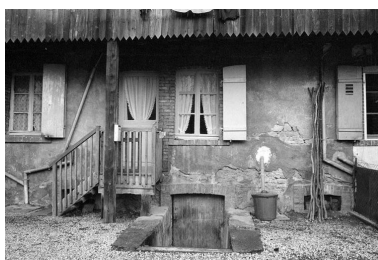
Immeuble situé 61 rue de Valentigney : détail de la façade postérieure. Phot. Bernard Lardière IVR43_19832500273Z
