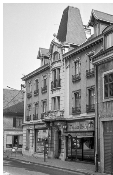
Immeuble situé 69 rue de Belfort. Phot. Bernard Lardière IVR43_19832500136Z
