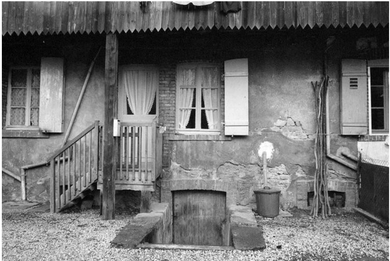
Immeuble situé 61 rue de Valentigney : détail de la façade postérieure.
