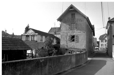
Immeuble situé 17 rue Neuve. Phot. Bernard Lardière IVR43_19832500188Z
