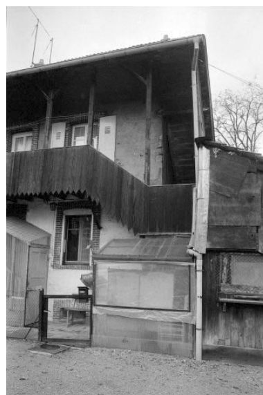
Immeuble situé 61 rue de Valentigney : détail de la façade postérieure. Phot. Bernard Lardière IVR43_19832500272Z
