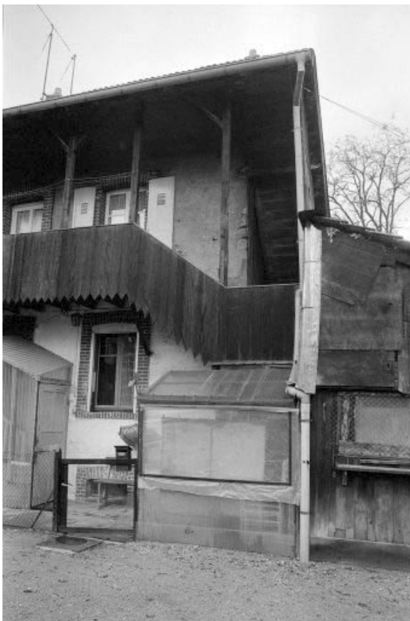
Immeuble situé 61 rue de Valentigney : détail de la façade postérieure.
