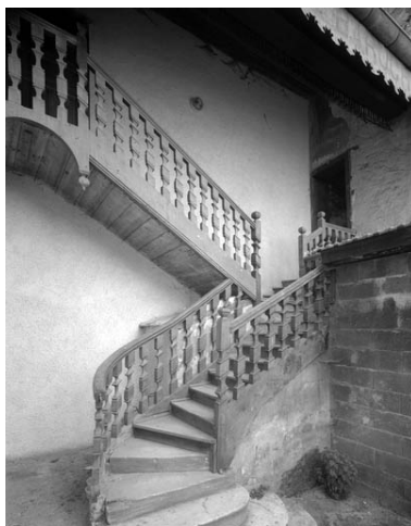
Détail de l'escalier extérieur : vue rapprochée. Phot. Yves Sancey IVR43_19917000156V
