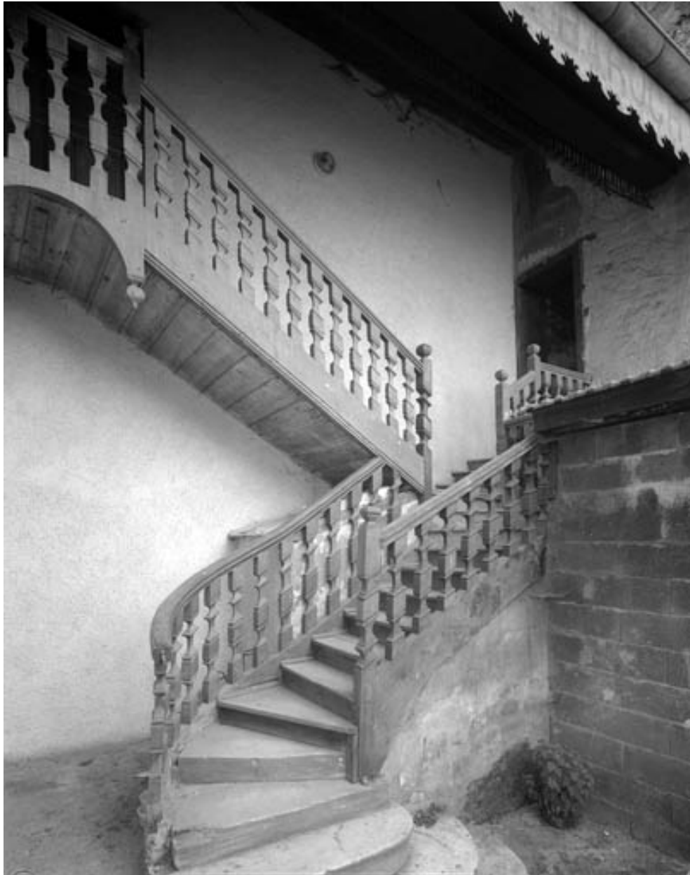
Détail de l'escalier extérieur : vue rapprochée.
