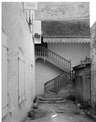
Détail de l'escalier extérieur : de face. Phot. Yves Sancey IVR43_19917000155V
