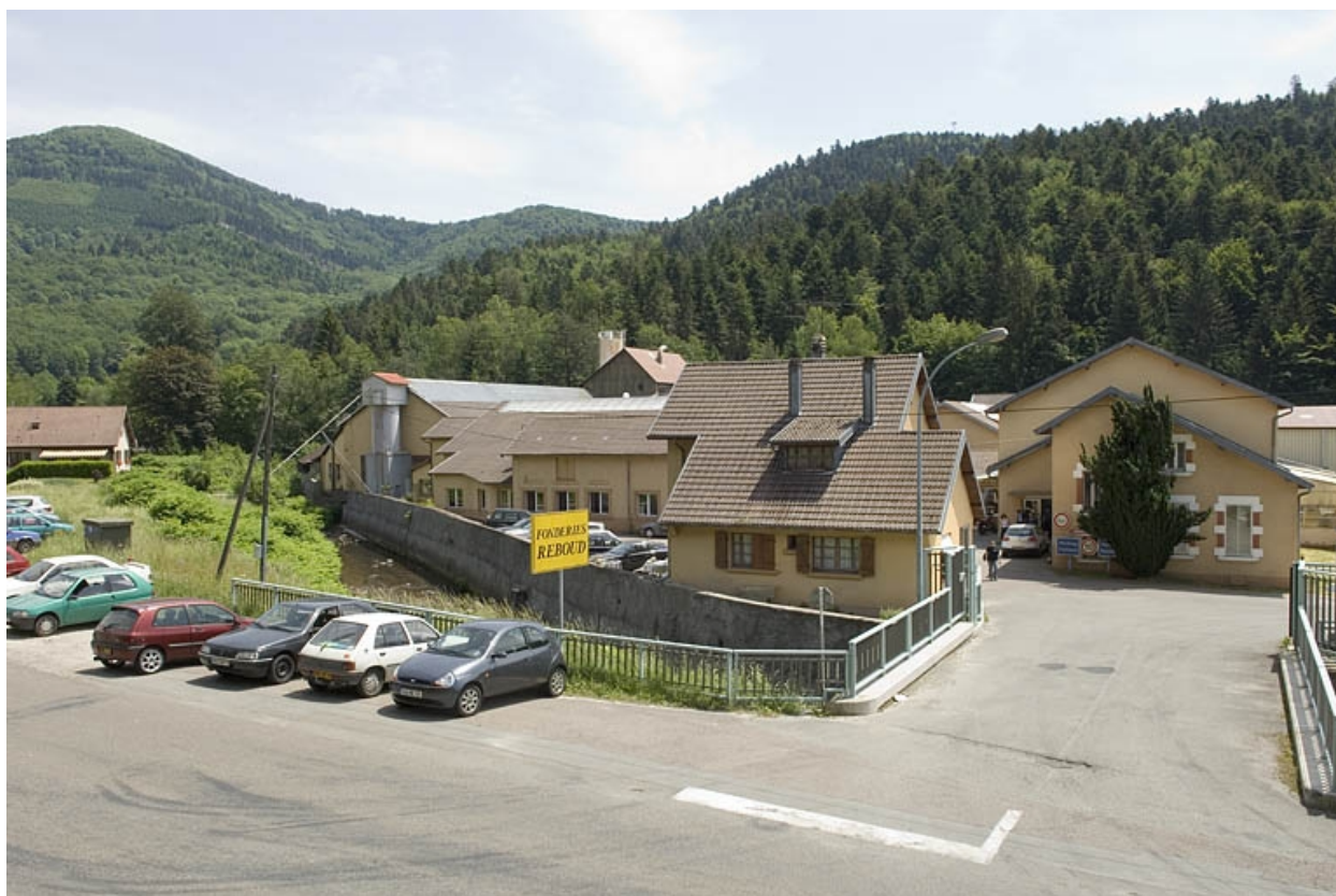
Partie nord de l'usine depuis l'entrée.
