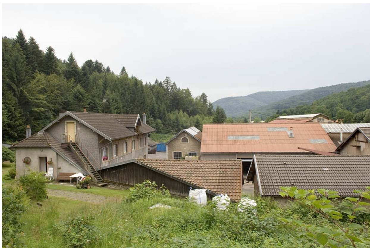
Logement et toitures des ateliers de fabrication.
