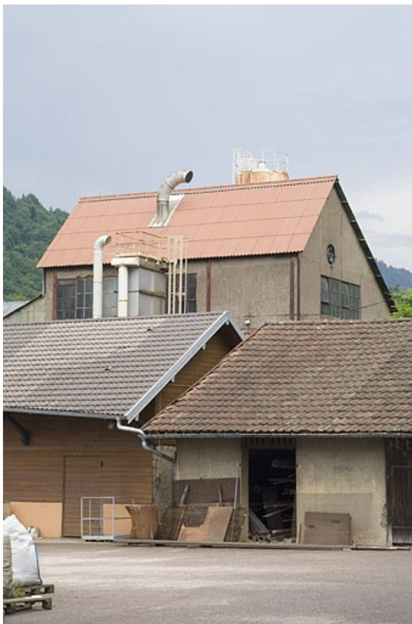
Atelier de fonderie depuis la cour est.
