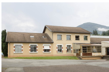
Façade sud des bureaux. Phot. Jérôme Mongreville IVR43_20097000807NUC2A
