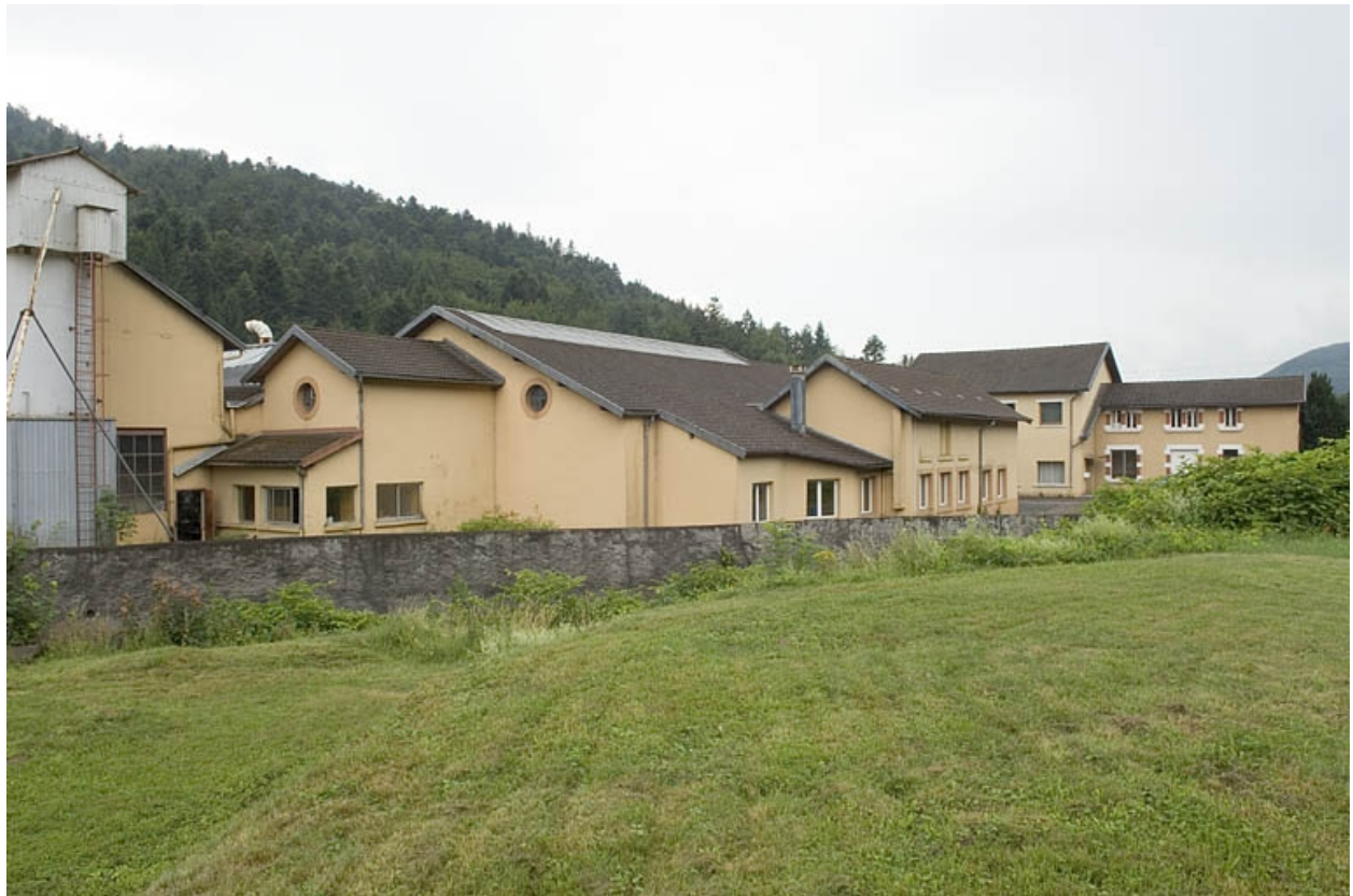
Ateliers de fabrication depuis le nord.
