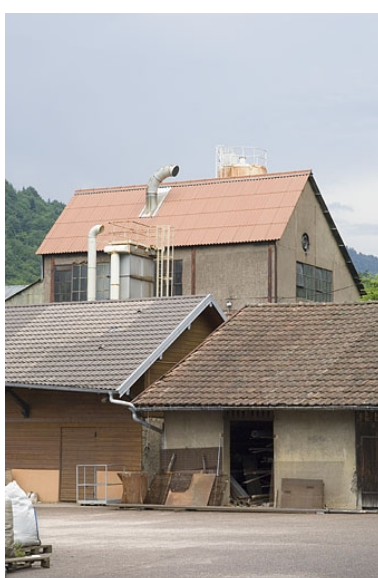
Atelier de fonderie depuis la cour est. Phot. Jérôme Mongreville IVR43_20097000814NUC2A
