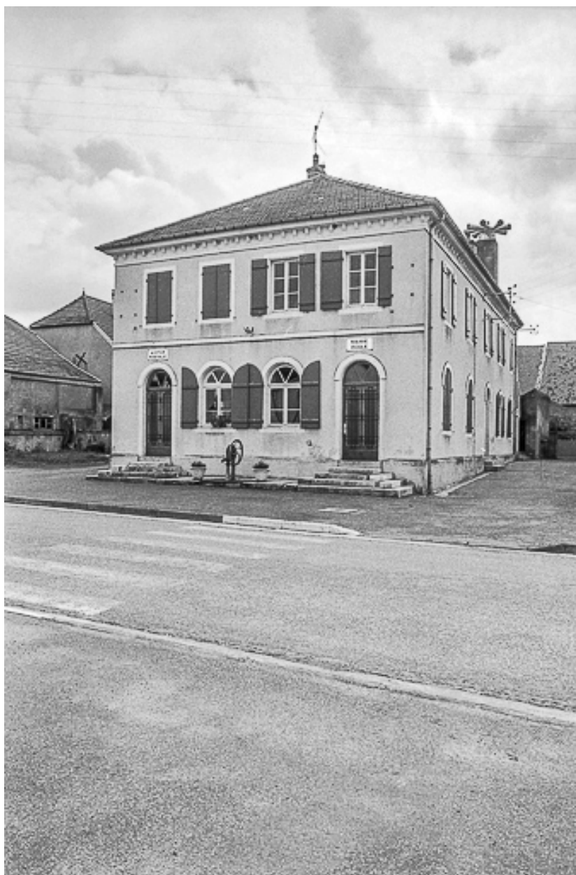
Façades antérieure et latérale droite.
