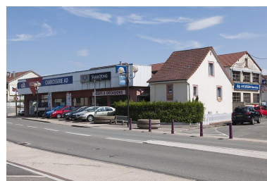
Vue d'ensemble depuis la route. Phot. Jérôme Mongreville IVR43_20112501234NUC4A
