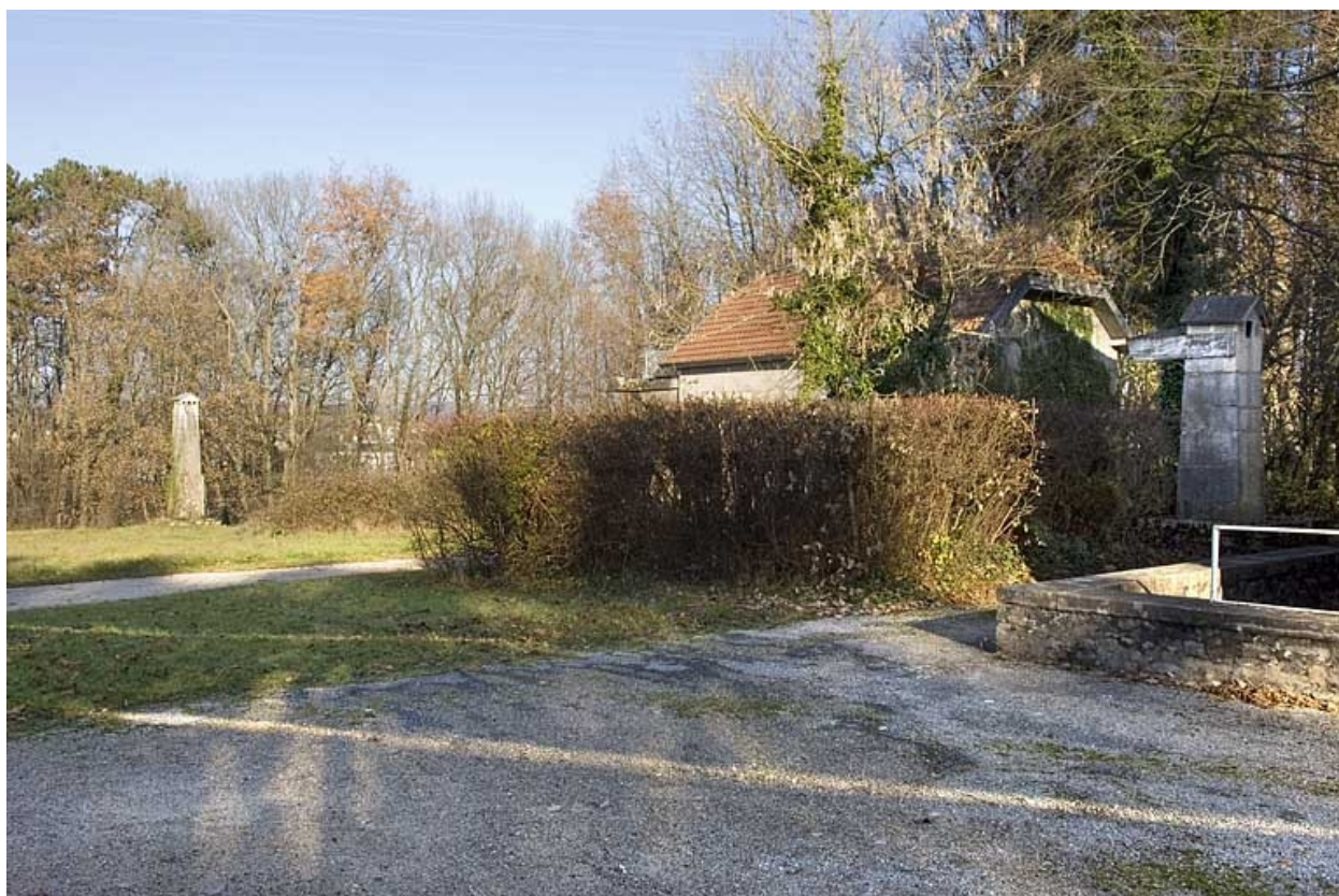
Mire nord de la lunette méridienne : pilier nord à gauche (mire) et pilier sud à droite (collimateur).
