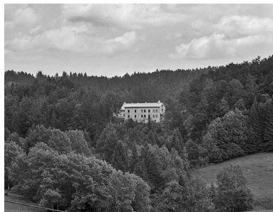
Vue de situation. Phot. Jérôme Mongreville IVR43_20003900162X
