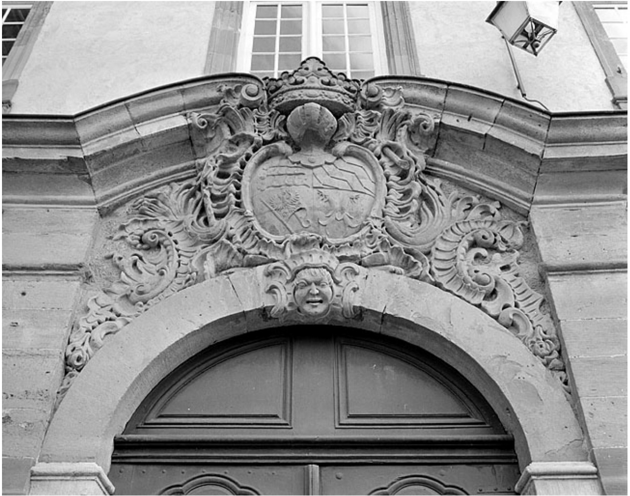
Détail du portail du corps de bâtiment principal.
