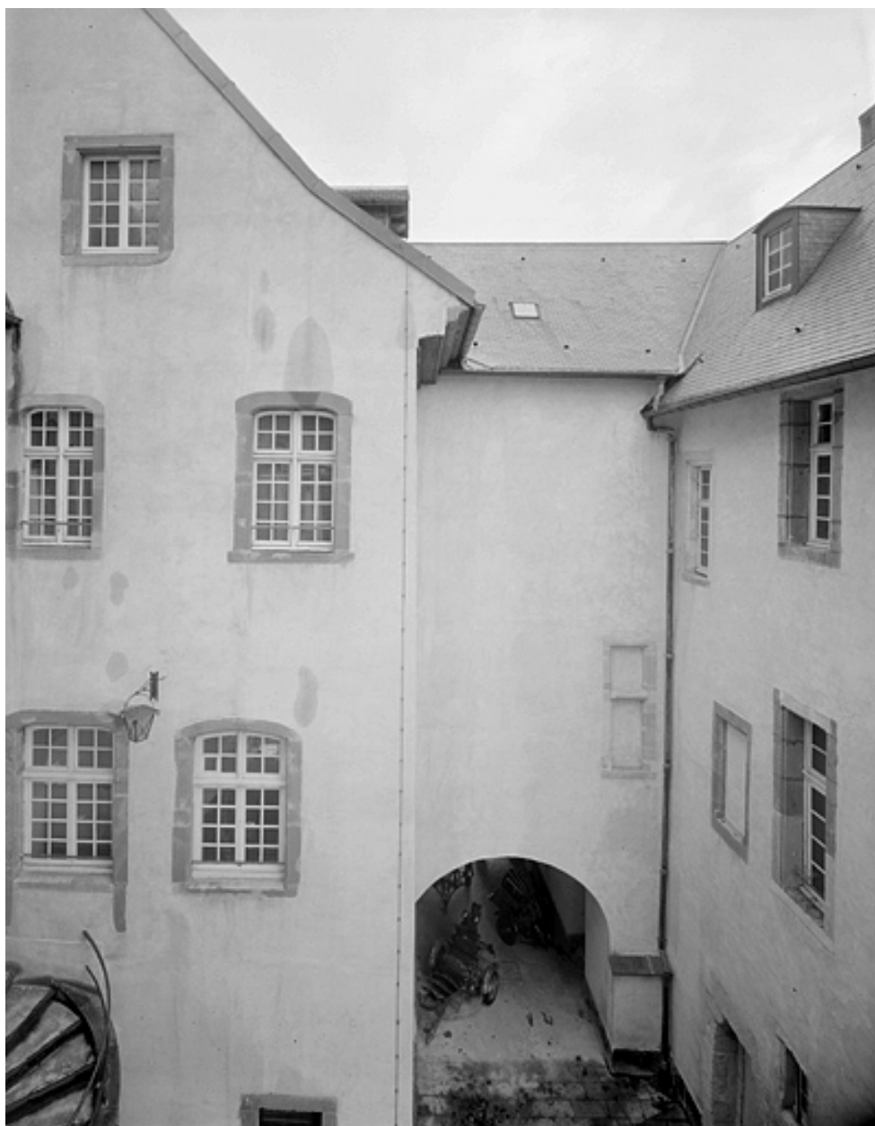
Cour de l'Ours. Au centre, passage conduisant à la cour principale ; à gauche, corps de bâtiment principal ; à droite, façade de la tour en éperon.
