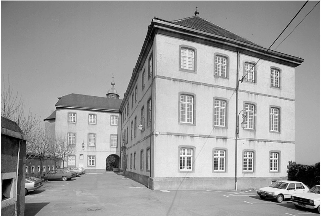
Corps de bâtiment principal vu depuis la basse-cour.
