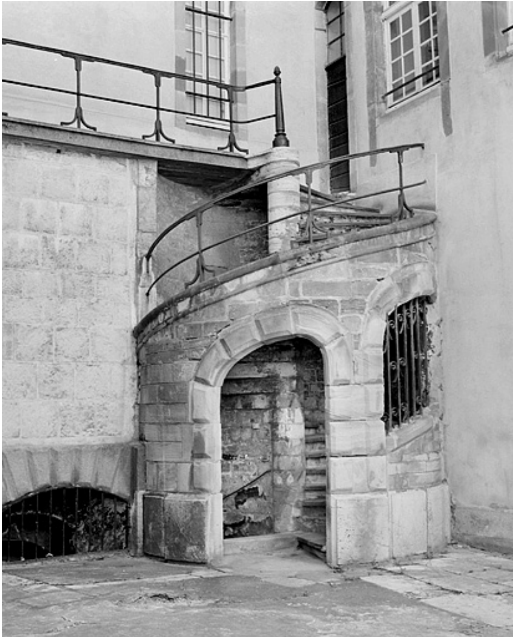
Cour de l'Ours. Escalier de la coursière.
