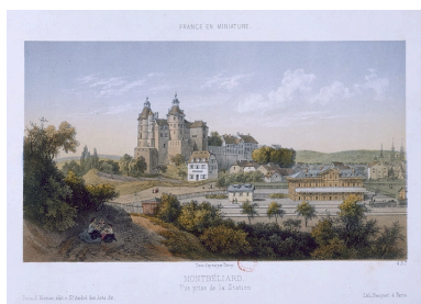
Montbéliard. Vue prise de la station, 2e moitié 19e siècle. Phot. Yves Sancey, Autr. Auguste Deroz IVR43_19872500403VA
