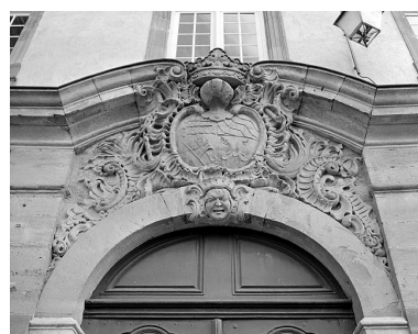
Détail du portail du corps de bâtiment principal.
