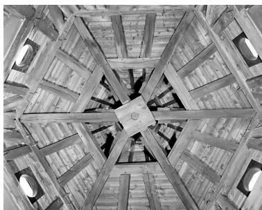
Tour Henriette. Charpente du lanteron. Phot. Jérôme Mongreville IVR43_19872500944X
