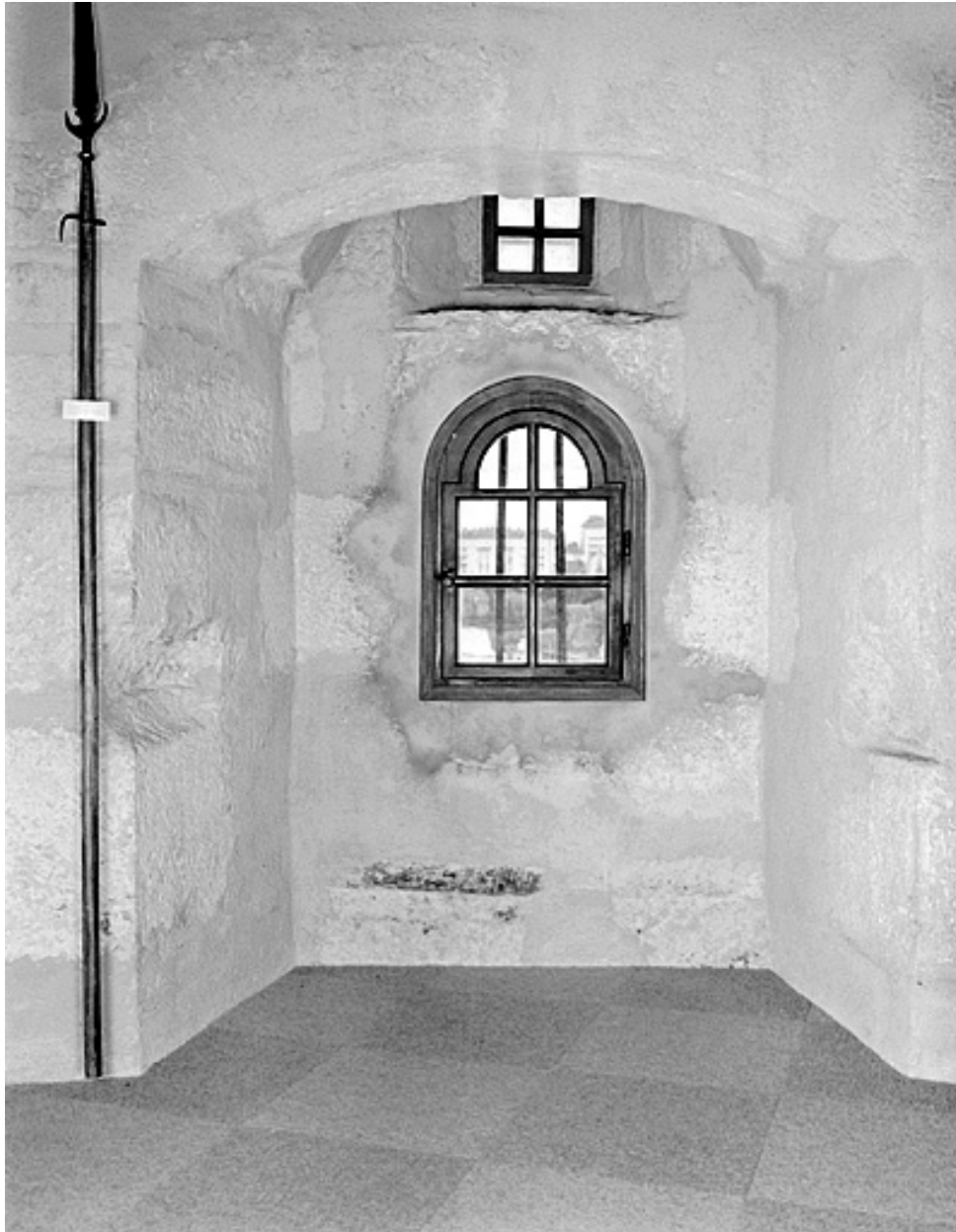
Tour Henriette. Fenêtre du troisième niveau.
