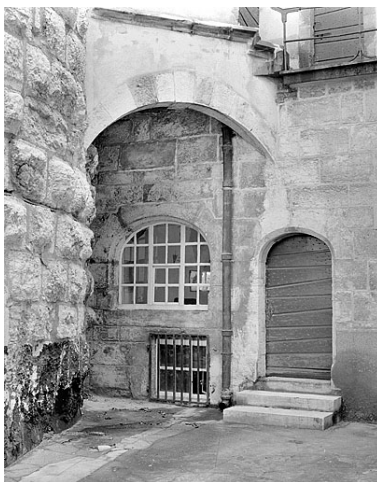
Arc soutenant la tourelle d'escalier de la tour Henriette. Phot. Jérôme Mongreville IVR43_19872500941X
