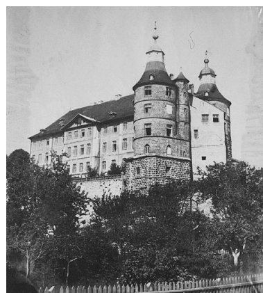
Vue de la partie sud-est du Neuf Château, 3e quart 19e siècle. IVR43_19862500212X
