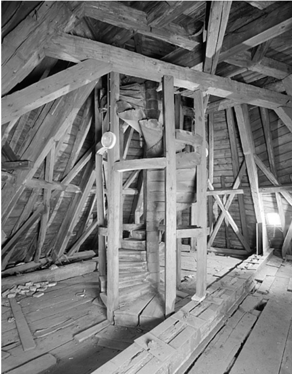
Tour Henriette. Charpente et escalier conduisant au lanternon.
