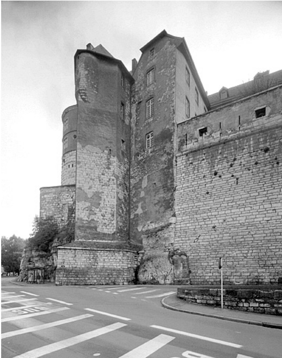
Tour en éperon et aile en retour du corps de logis principal.
