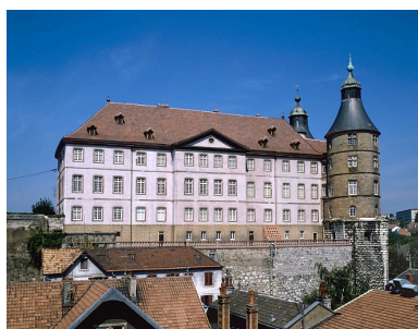
Corps de bâtiment principal. Côté sud. Phot. Jérôme Mongreville IVR43_19872500373XA
