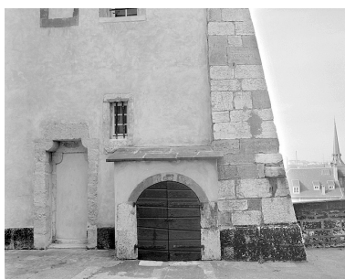
Façade sur la cour de l'Ours de la tour en éperon. A gauche, ancienne entrée de la salle du rez-de-chaussée ; à droite, porte ouvrant sur un escalier droit conduisant à la salle du puits.
