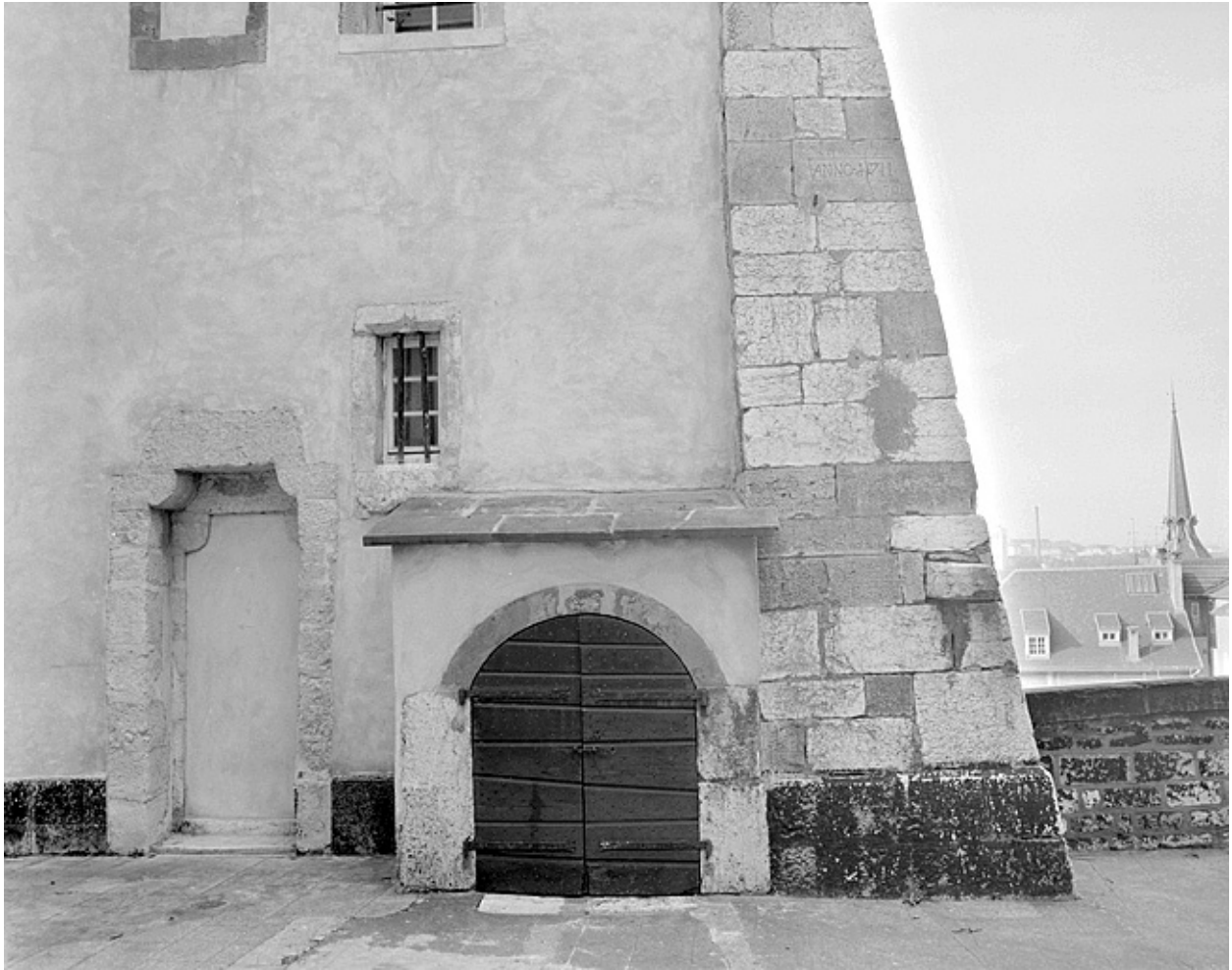
Façade sur la cour de l'Ours de la tour en éperon. A gauche, ancienne entrée de la salle du rez-de-chaussée ; à droite, porte ouvrant sur un escalier droit conduisant à la salle du puits.
