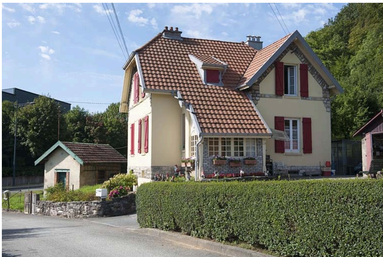
Maison jumelée. Façade est.
