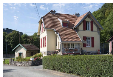
Maison jumelée. Façade est. Phot. Jérôme Mongreville IVR43_20112502138NUC4A
