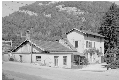
Vue d'ensemble depuis le sud. Phot. Laurent Poupard IVR43_19903900572Z
