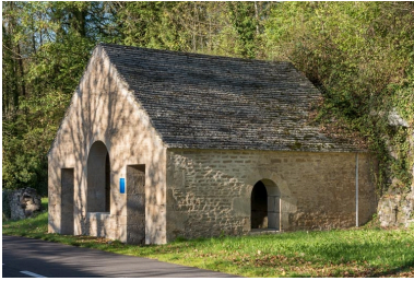
Vue d'ensemble depuis le sud-est. Phot. Pierre-Marie Barbe-Richaud IVR26_20222101100NUC4A
