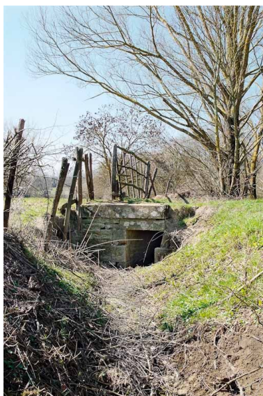
L'aqueduc, vue d'ensemble. Phot. Jean-Luc Duthu IVR26_20107100467NUC2A
