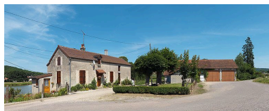
Vue d'ensemble. Phot. Thierry Kuntz IVR26_20122102046NUC4AQ
