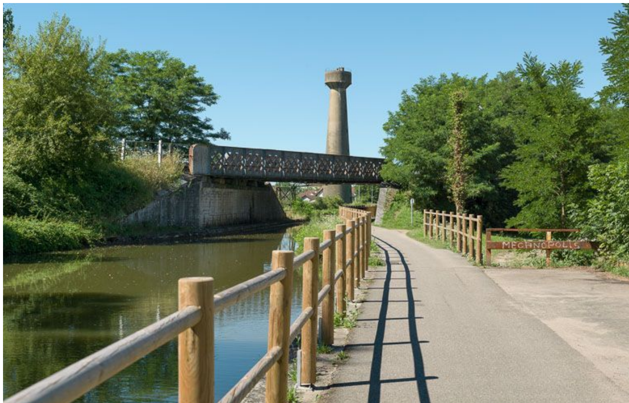
Le pont ferroviaire vu d'amont.
