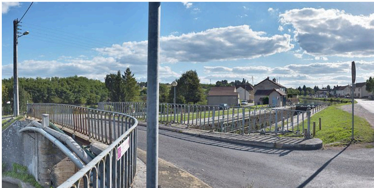
Le site d'écluse 05 vu d'aval. Pont sur écluse.
