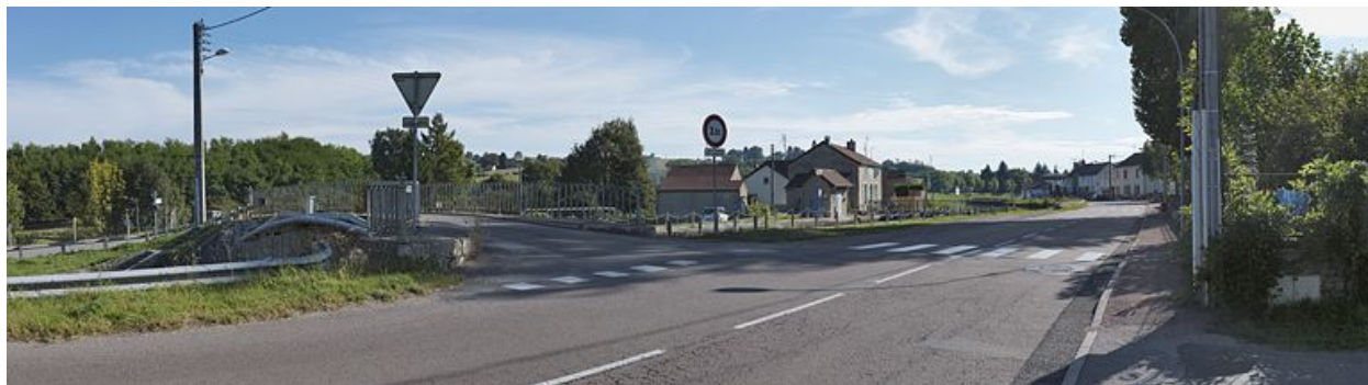
Le site d'écluse 05 vu d'aval. Pont sur écluse.
