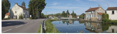
Le site d'écluse 05 vu d'amont. De gauche à droite : le café-restaurant des Amis du Canal, le site d'écluse avec son pont. On distingue le déversoir menant à la rigole régulatrice des biefs. La maison éclusière en amont du sas. Phot. Thierry Kuntz IVR26_20127100365NUC4AQ
