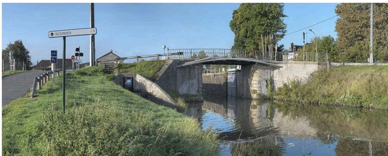
Le site d'écluse 05 vu du bief 06. Pont sur écluse avec escalier. Arrivée de la rigole régulatrice des biefs.
