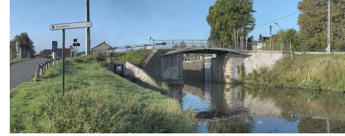
Le site d'écluse 05 vu du bief 06. Pont sur écluse avec escalier. Arrivée de la rigole régulatrice des biefs. Phot. Thierry Kuntz IVR26_20127100370NUC4AQ
