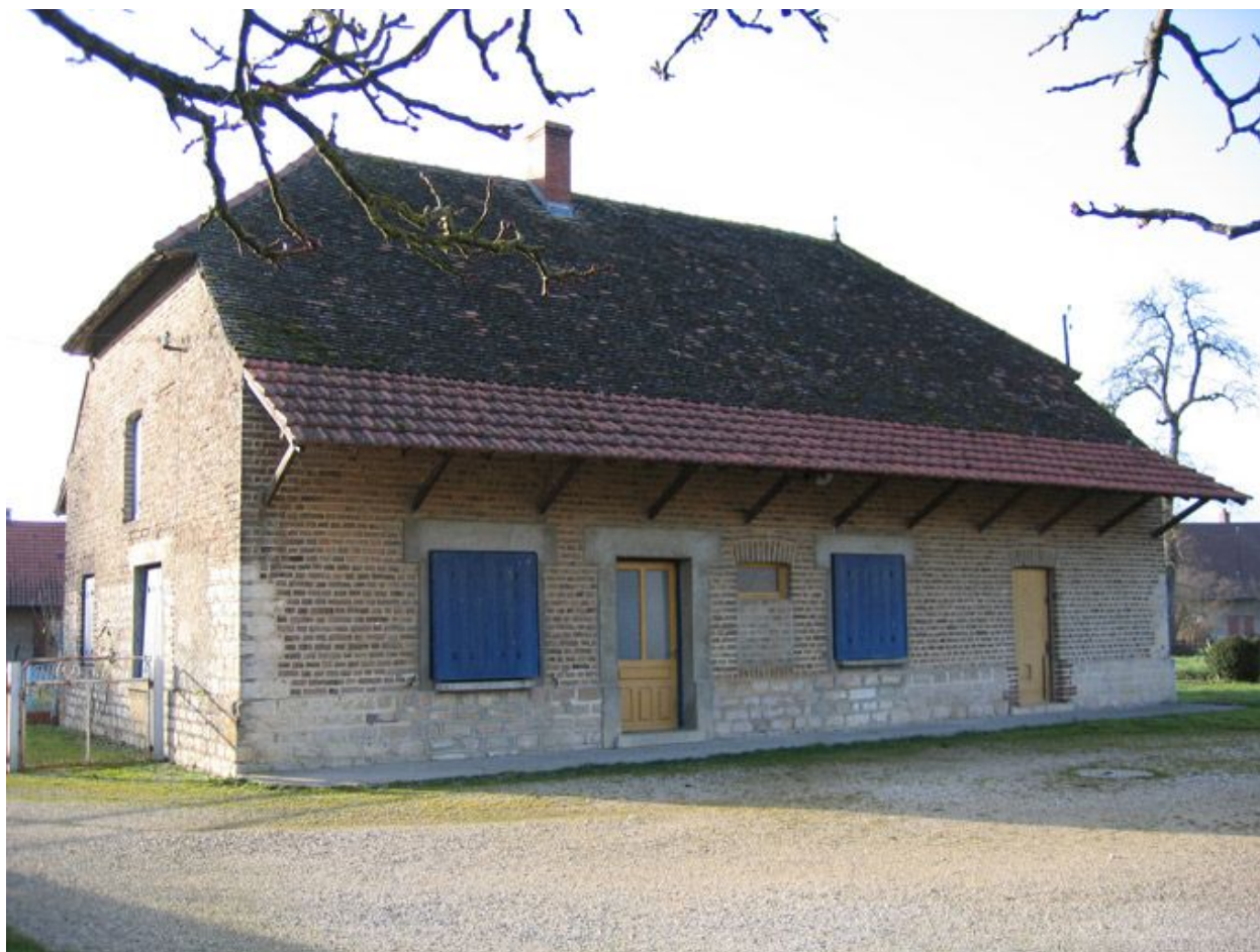
Vue d'ensemble de la façade de l'habitation.
