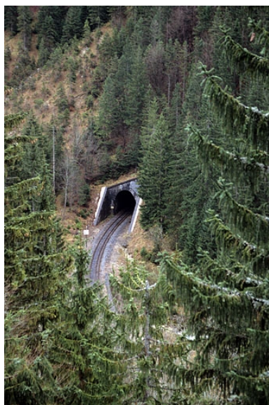
Vue d'ensemble plongeante sur la tête côté La Cluse. Phot. Yves Sancey IVR43_20053900383ZA
