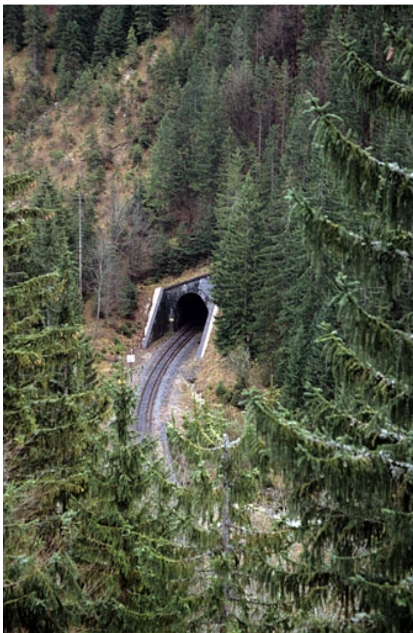
Vue d'ensemble plongeante sur la tête côté La Cluse.
