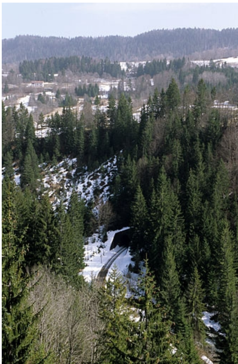
Vue d'ensemble plongeante sur la tête côté Andelot-en-Montagne.
