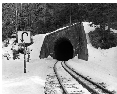
Tête côté La Cluse. Signalant un tunnel à mauvaise ventilation, le panneau autorise le train à " refouler " (faire marche
