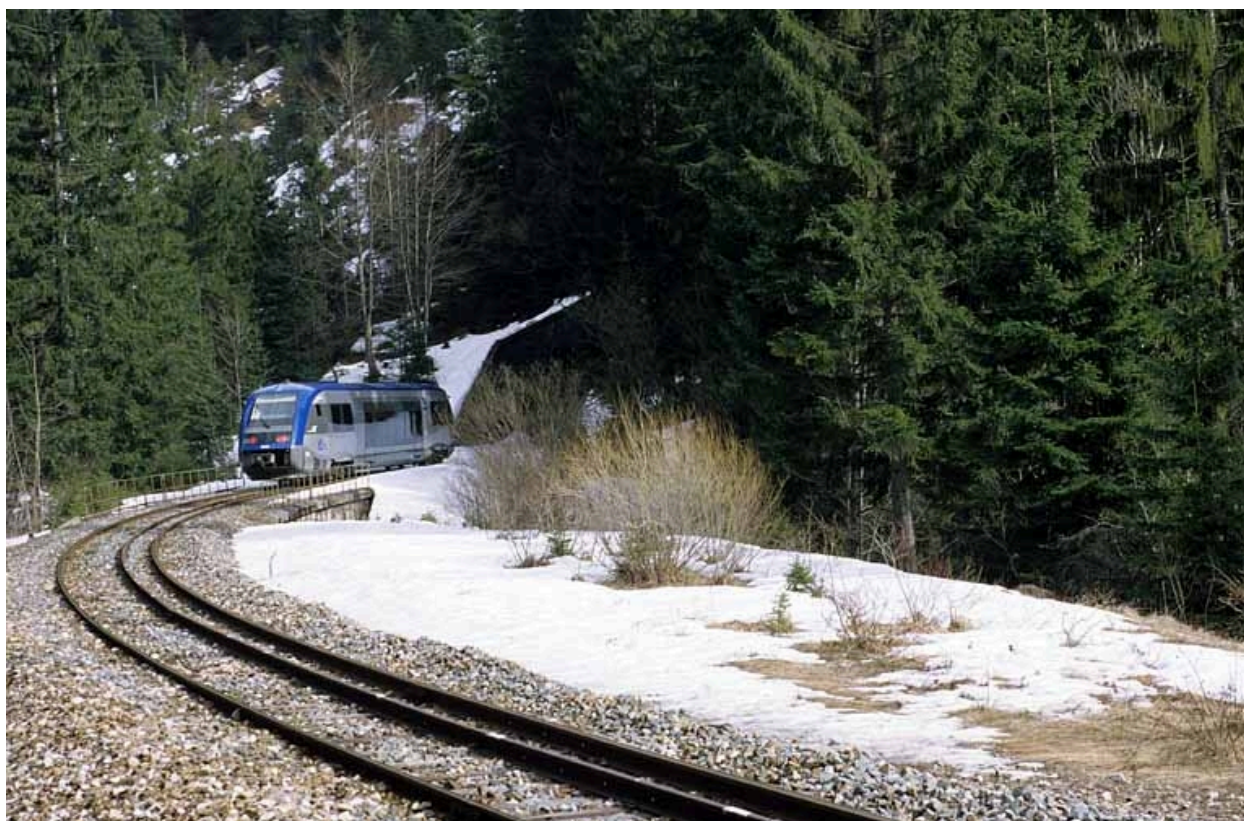
Vue d'ensemble de la voie vers la tête côté Andelot-en-Montagne, avec autorail X 73500.
