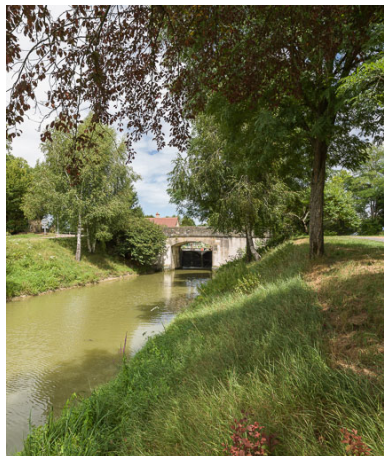
Vue du pont.
