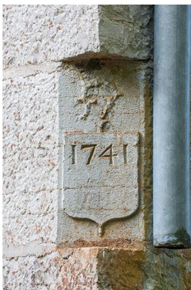
Moulin nord. Pierre d'angle nord-est. Phot. Jérôme Mongreville
