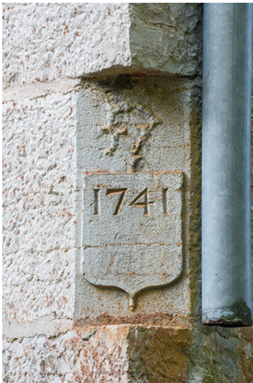
Moulin nord. Pierre d'angle nord-est.
