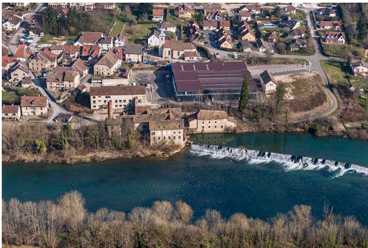
Vue d'ensemble plongeante depuis le sud.
