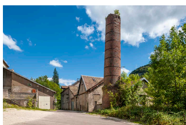
Vue des bâtiments du moulin depuis l'ouest. Phot. Jérôme Mongreville IVR43_20142501105NUC4A
