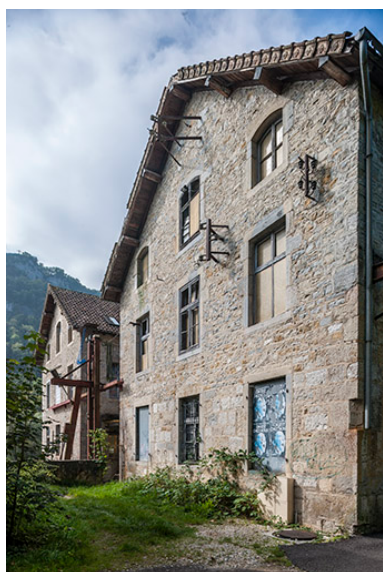
Murs pignons est du moulin. Phot. Jérôme Mongreville
