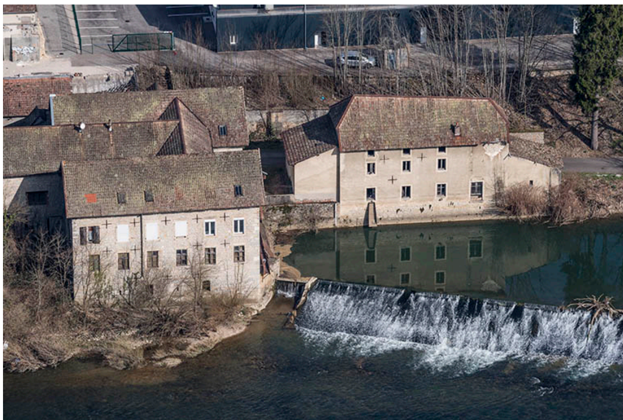
Vue plongeante rapprochée depuis le sud.
