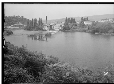
[Vue d'ensemble depuis le sud-ouest], s.d. [vers 1930] Phot. Jules Manias IVR43_20062501168P
