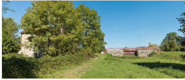
L'ancien site avec à gauche la maison éclusière. Phot. Pierre-Marie Barbe-Richaud IVR26_20135800467NUC4AQ
