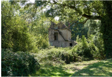
L'ancienne maison éclusière. Phot. Pierre-Marie Barbe-Richaud IVR26_20135800466NUC4AQ
