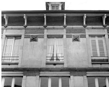
Détail de la façade sur la rue du Puits. Phot. Jérôme Mongreville IVR43_19872500810X
