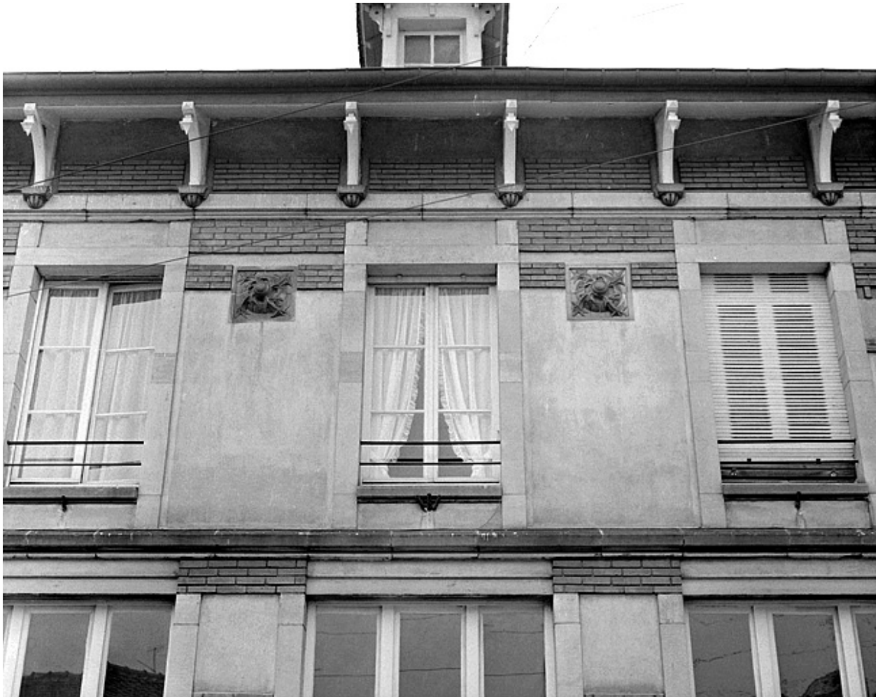
Détail de la façade sur la rue du Puits.
