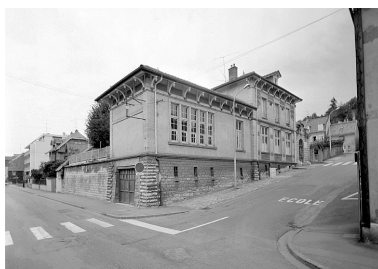
Vue d'ensemble à l'angle de la rue du Puits et de la rue Saint-Georges. Phot. Jérôme Mongreville IVR43_19872500273V
