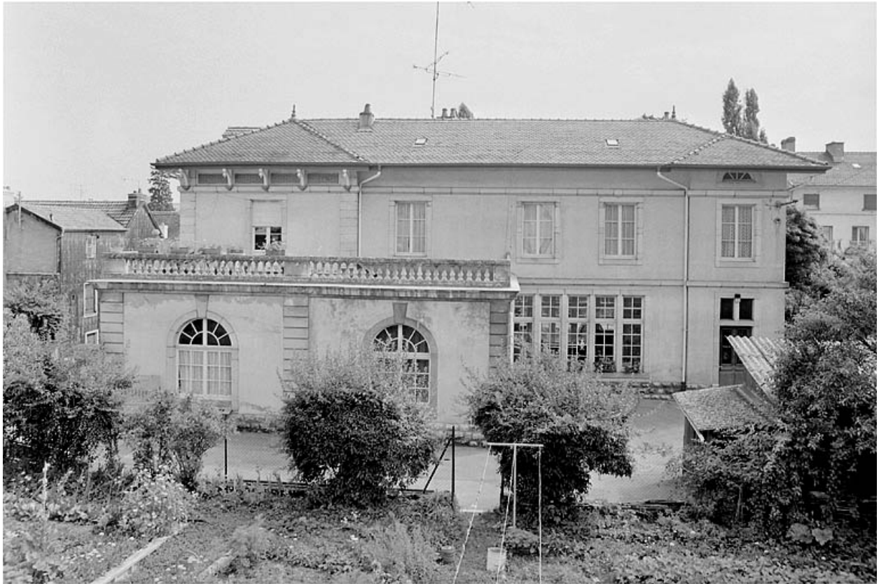
Façades sur le jardin.
