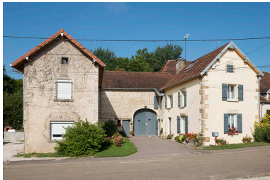
Emplacement de la ferme depuis la rue. Phot. Jérôme Mongreville IVR43_20177000182NUC4A
