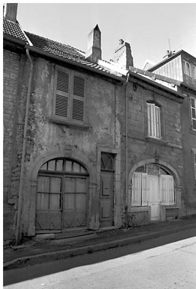
Maison de commerçant située Grande Rue. Phot. Bernard Lardière IVR43_19797000409Z
