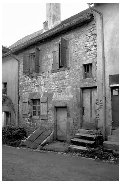
Maison située rue Gambetta. Phot. Bernard Lardière IVR43_19797000386Z
