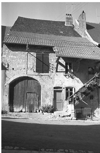
Ferme située rue Gambetta. Phot. Bernard Lardière IVR43_19797000397Z
