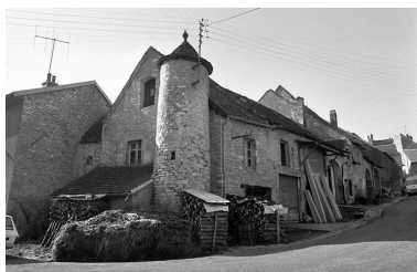
Maison située rue Gambetta. Phot. Bernard Lardière IVR43_19797000383Z
