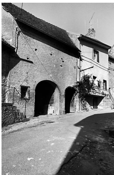
Maison située rue Bizot. Phot. Bernard Lardière IVR43_19797000405Z
