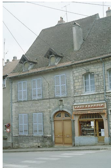
Maison située rue Grande Rue. Phot. Yves Sancey IVR43_19827000522XA
