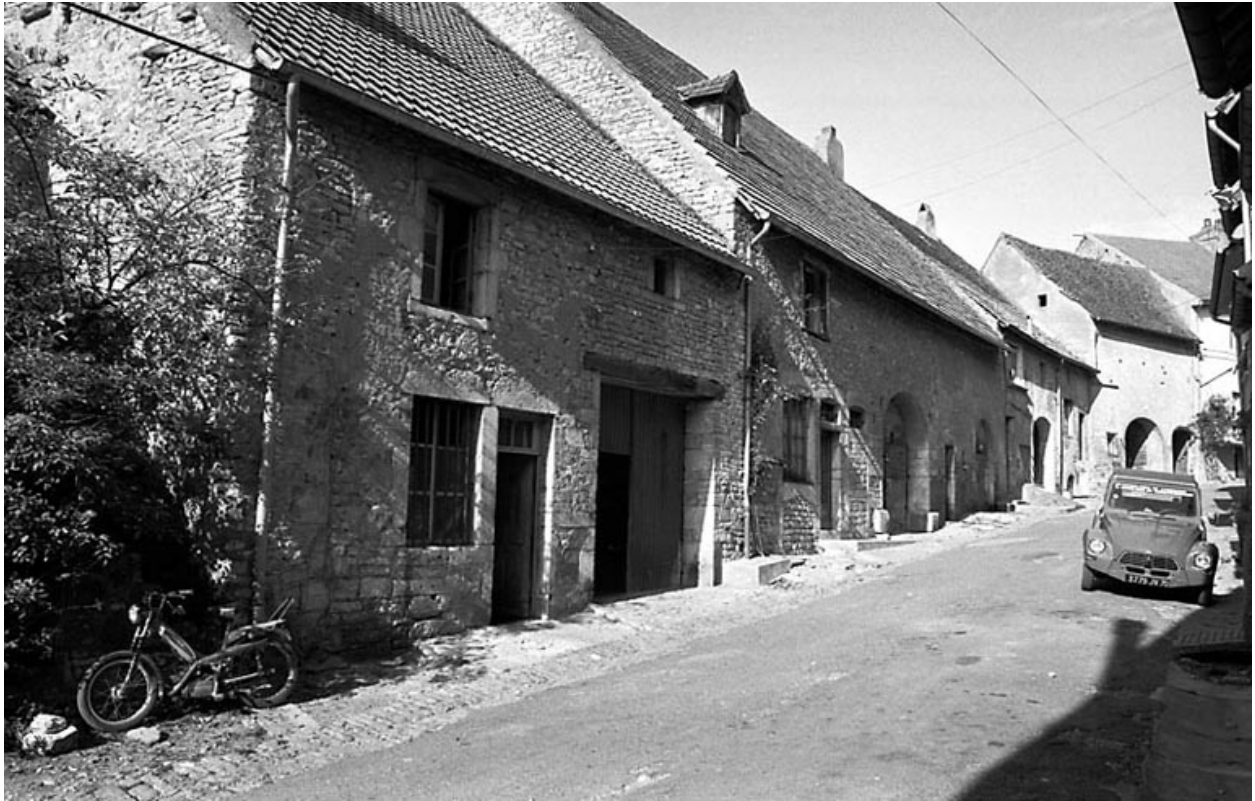
Ferme située rue Bizot.
