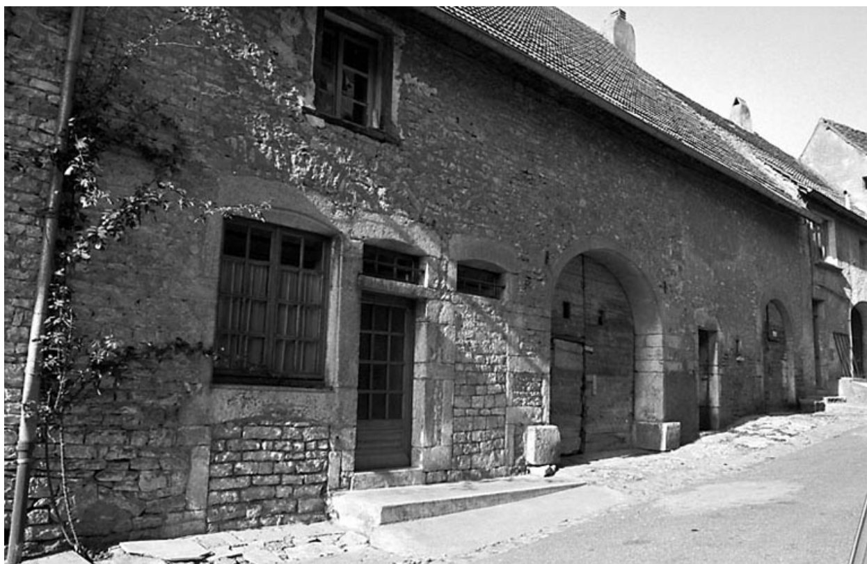
Ferme située rue Bizot.
