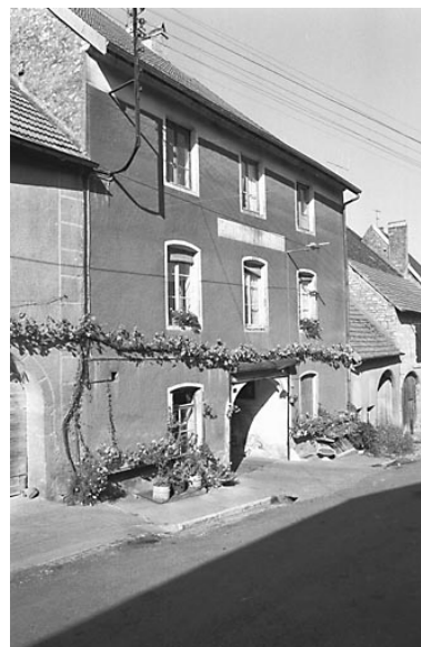
Maison située rue Gambetta. Phot. Bernard Lardière IVR43_19797000394Z
