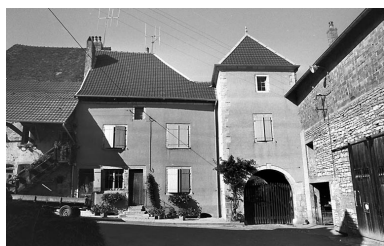
Ferme située rue Gambetta. Phot. Bernard Lardière IVR43_19797000398Z
