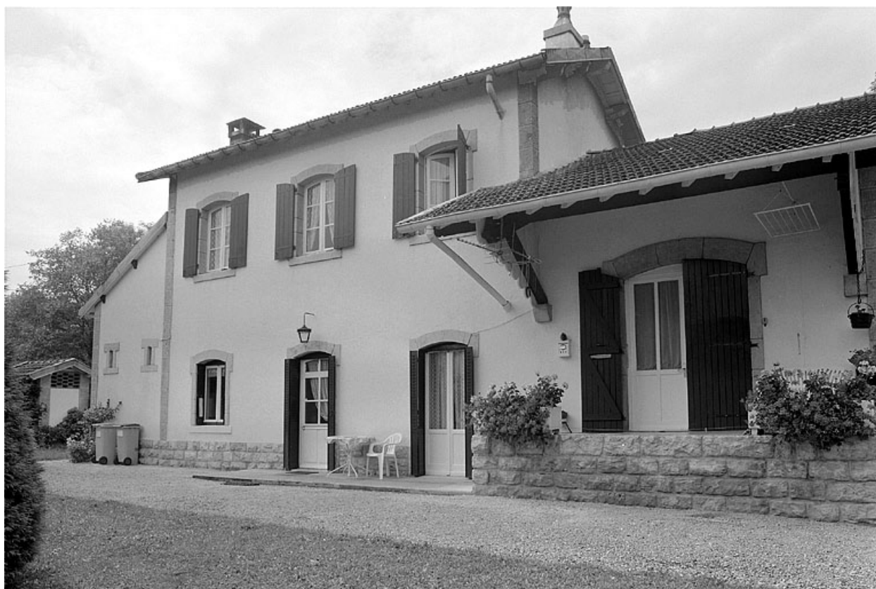
Façade sur la voie ferrée.
