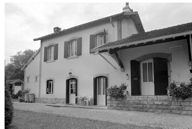
Façade sur la voie ferrée. Phot. Jérôme Mongreville IVR43_19963900997X
