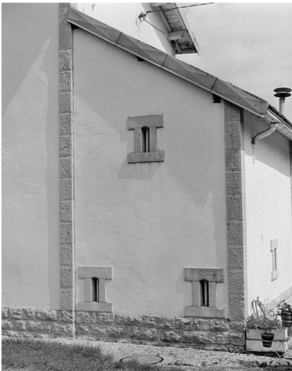
Ouvertures dans la partie abritant l'escalier.
