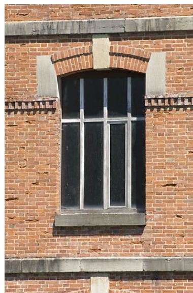
Détail d'une fenêtre du bâtiment d'eau. Phot. Jérôme Mongreville IVR43_20087000903NUC2A
