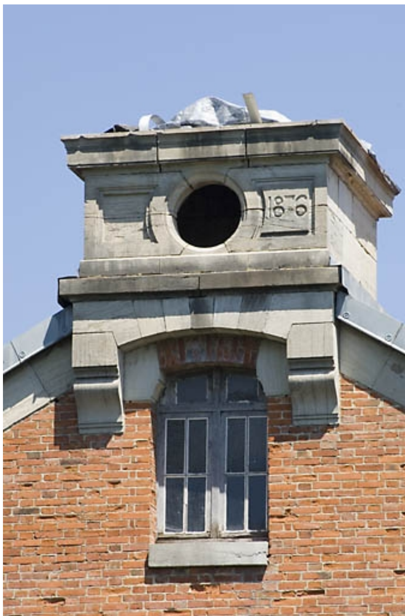
Couronnement de façade sud du bâtiment d'eau.
