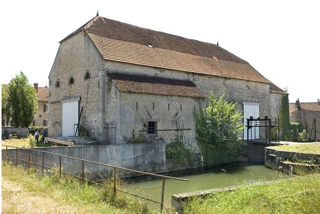
Vue du haut fourneau depuis l'ouest.
