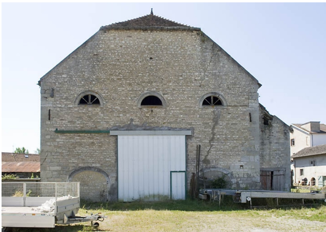
Mur-pignon nord du haut fourneau.
