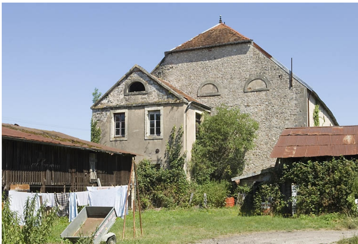
Le haut fourneau vu depuis le sud.
