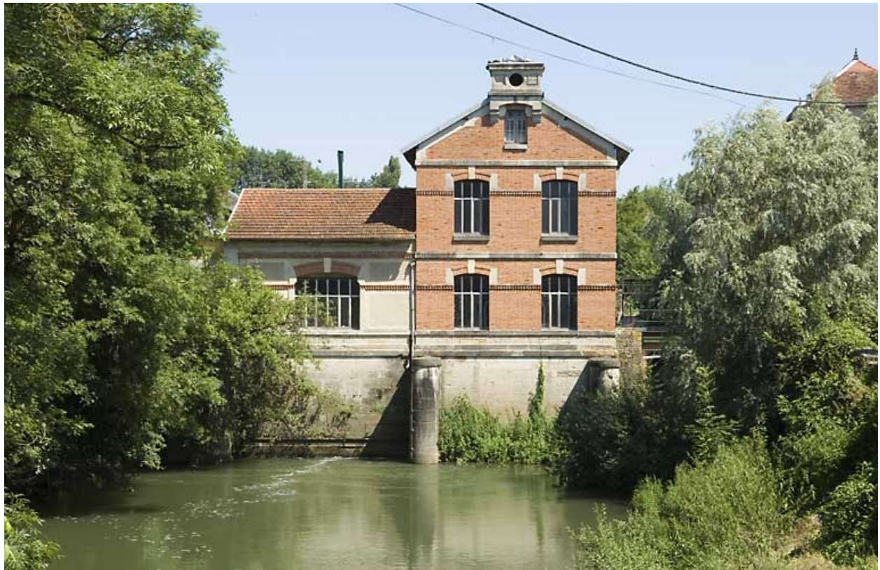
Vue rapprochée du bâtiment d'eau.
