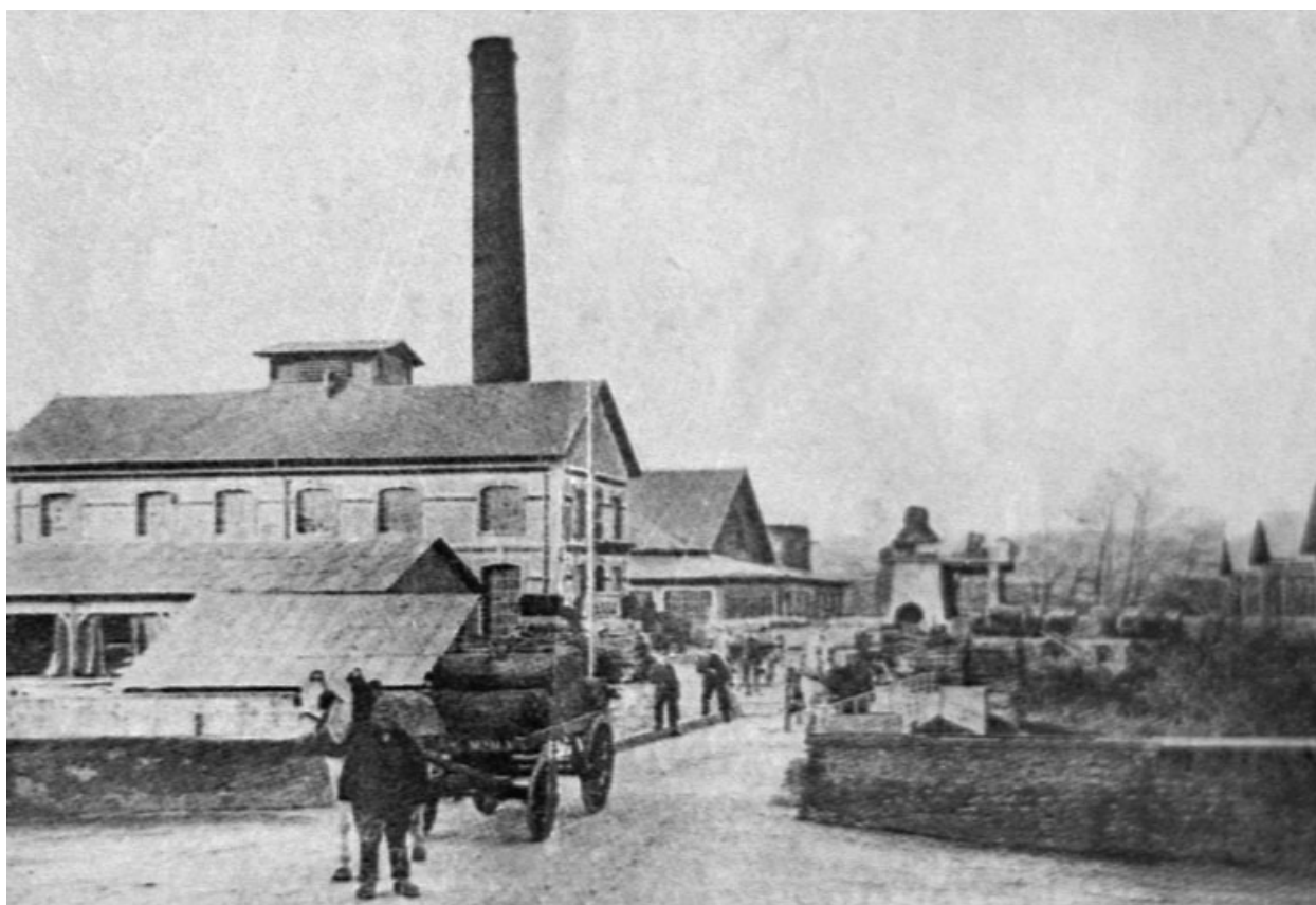
Usine de Seveux (Haute-Saône).
