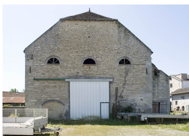
Mur-pignon nord du haut fourneau. Phot. Jérôme Mongreville IVR43_20087000900NUC2A
