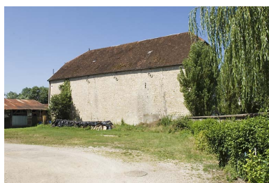
Façade est du haut fourneau. Phot. Jérôme Mongreville IVR43_20087000889NUC2A
