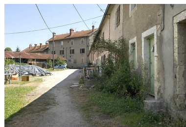
Logements ouvriers sur cour. Phot. Jérôme Mongreville IVR43_20087000892NUC2A
