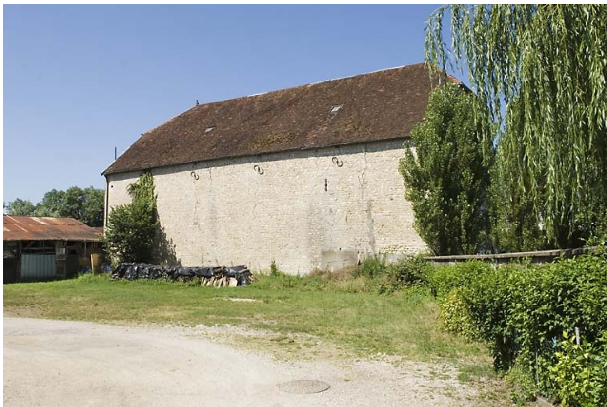
Façade est du haut fourneau.
