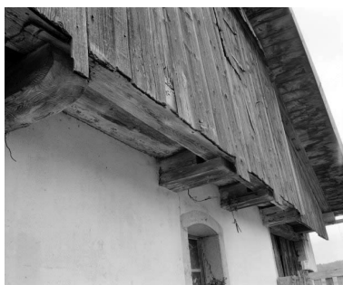
Surplomb de la lambrechure antérieure : rang de planches. Phot. Yves Sancey IVR43_19772500355X
