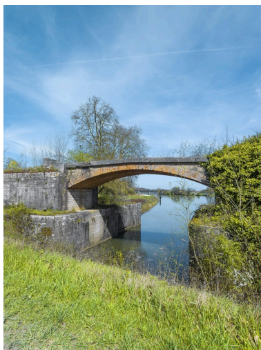
Vue d'ensemble. En arrière-plan le pont ferroviaire (IA21005578). Phot. Thierry Kuntz IVR26_20162101415NUC4A
