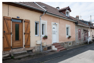
Façades nord rue de la 3e Cité. Phot. Jérôme Mongreville IVR43_20142501344NUC4A
