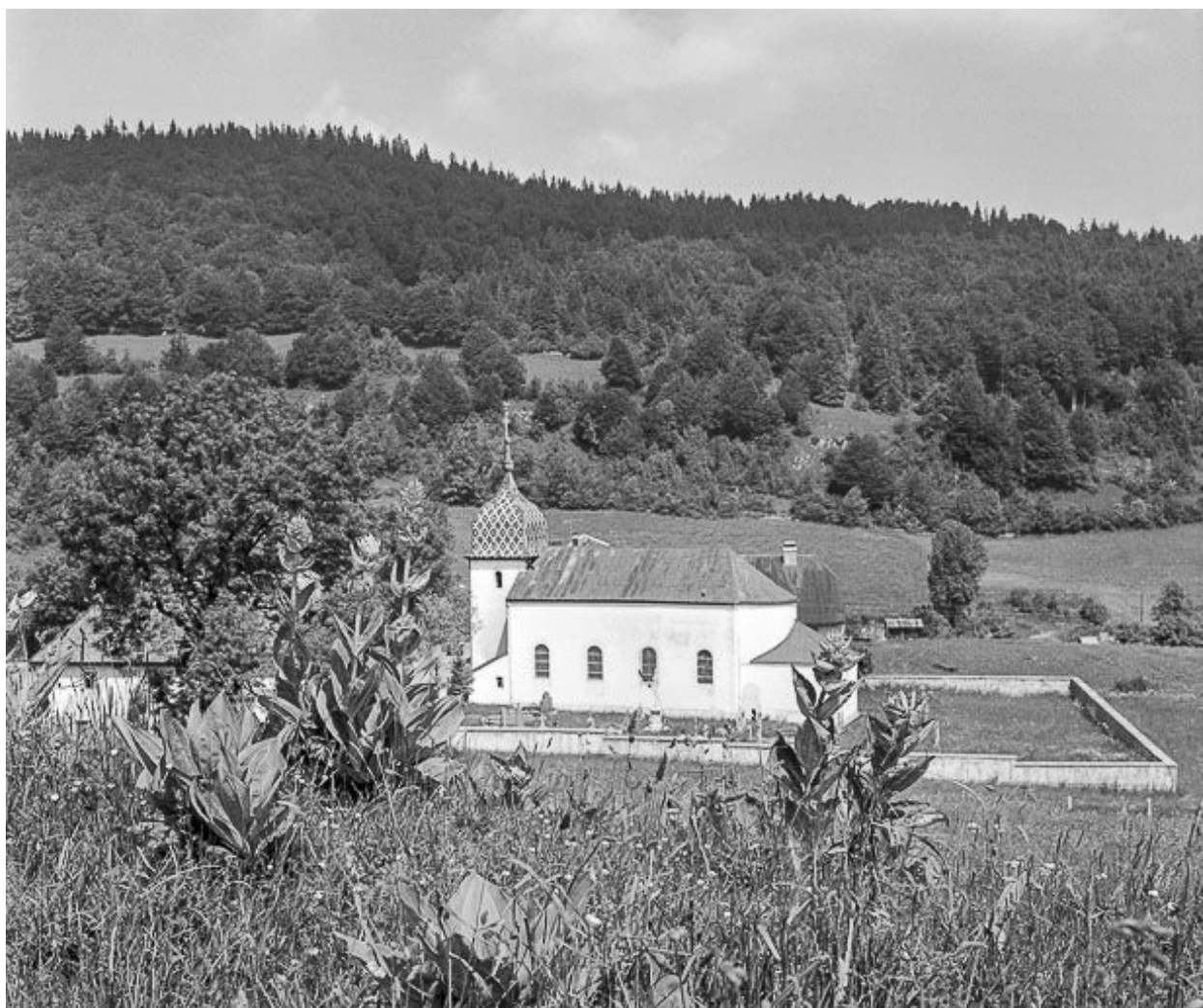
Vue d'ensemble dans le site.
