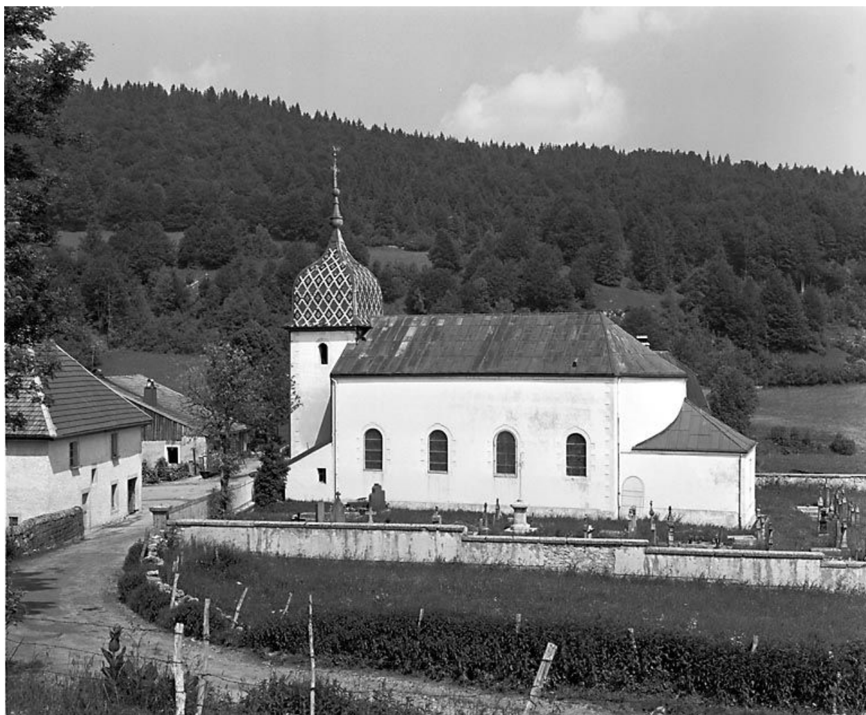
Façade latérale droite.
