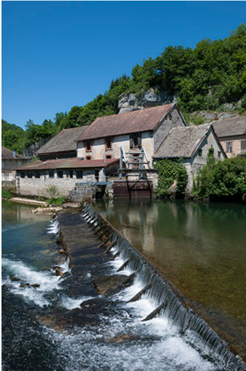
Vue d'ensemble depuis la tête amont du barrage.
