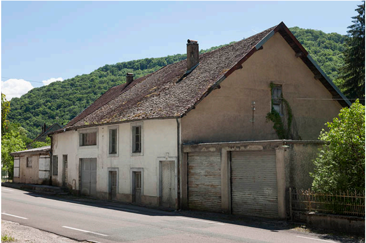
Vue rapprochée depuis le nord-ouest.
