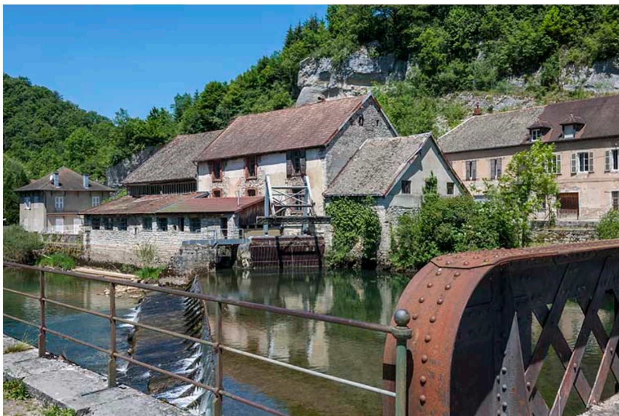
Vue d'ensemble depuis le pont, rive gauche.
