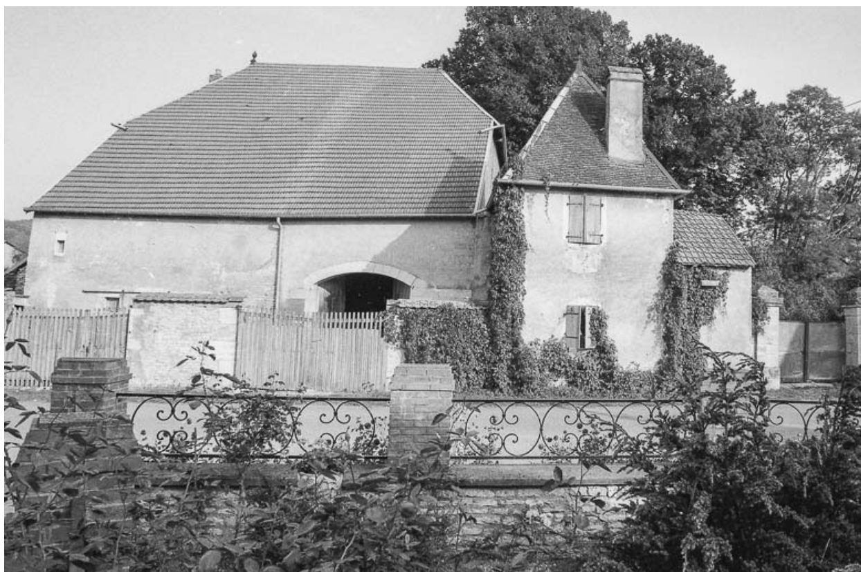
Maison située rue Basse.
