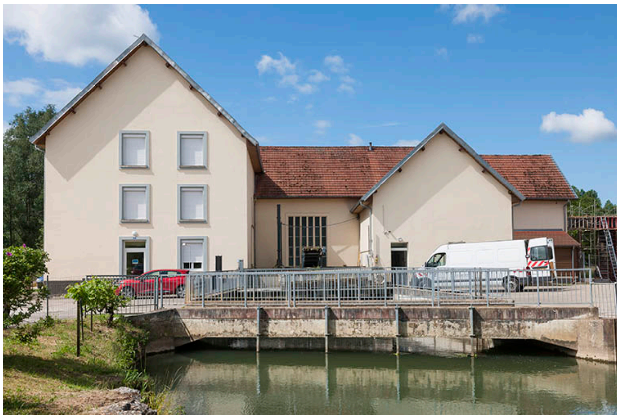
La centrale hydroélectrique depuis le canal d'amenée.
