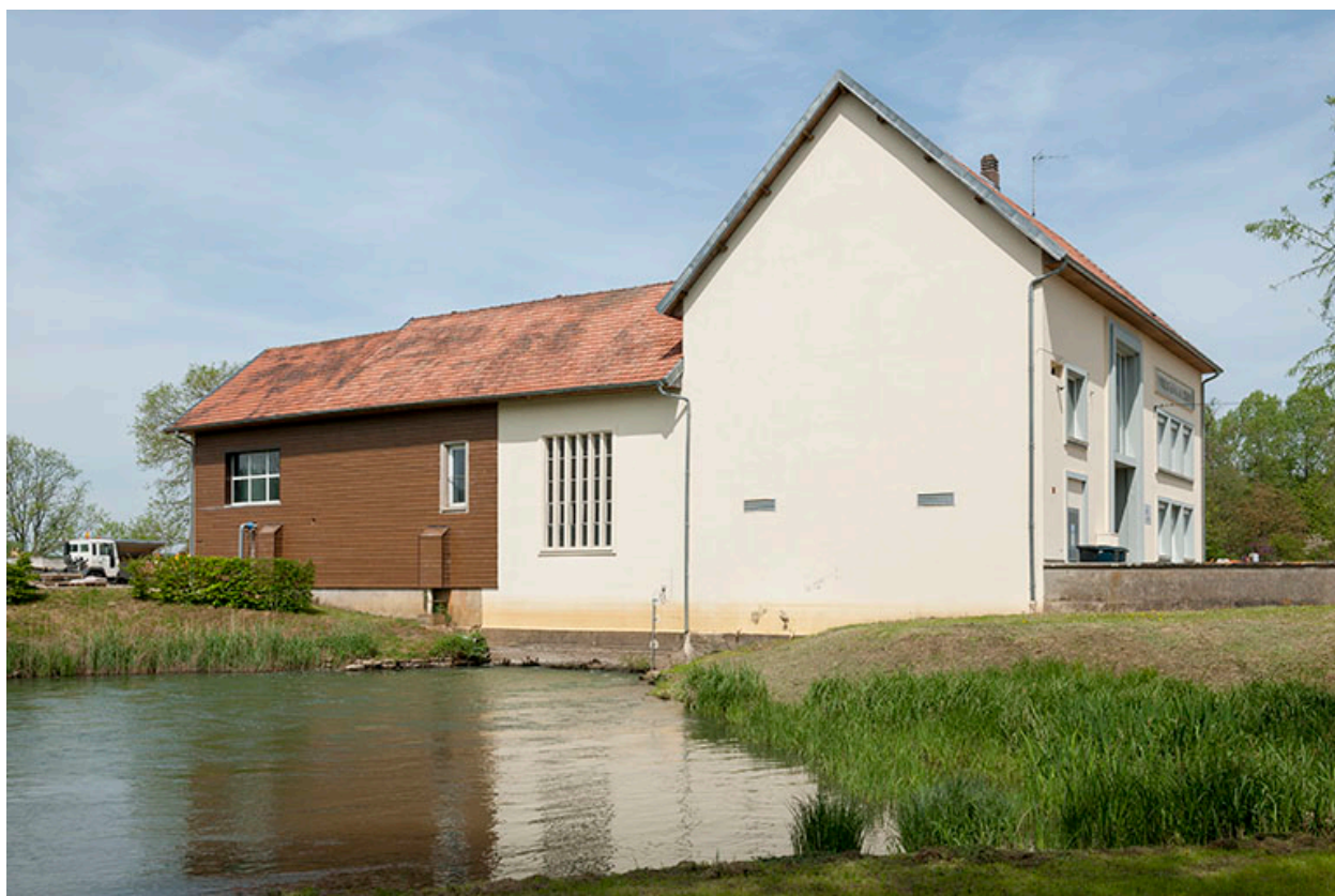
La centrale hydroélectrique vue depuis le sud.
