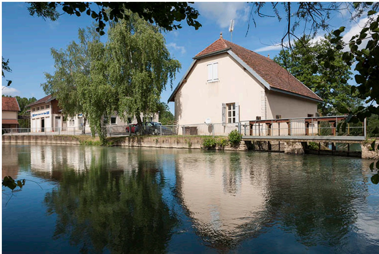
Vue depuis le début du canal d'amenée.
