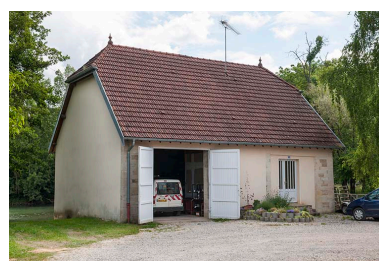
Garage et logement (ancien atelier de scierie). Phot. Jérôme Mongreville IVR43_20152501231NUC4A
