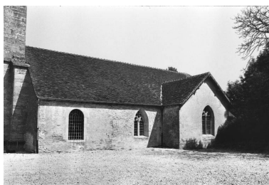
Façade latérale droite. Phot. Guy Forestier IVR43_19743901017Z
