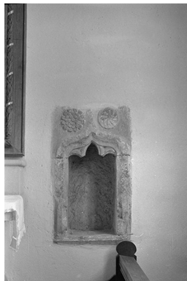
Lavabo en niche : vue de face. Phot. Guy Forestier IVR43_19743900345Z
