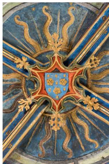
Clef de voûte de la travée occidentale. IVR26_20237100170NUC4A
