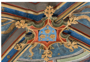
Clef de voûte de la travée occidentale. Phot. Pierre-Marie Barbe-Richaud IVR26_20237100171NUC2A
