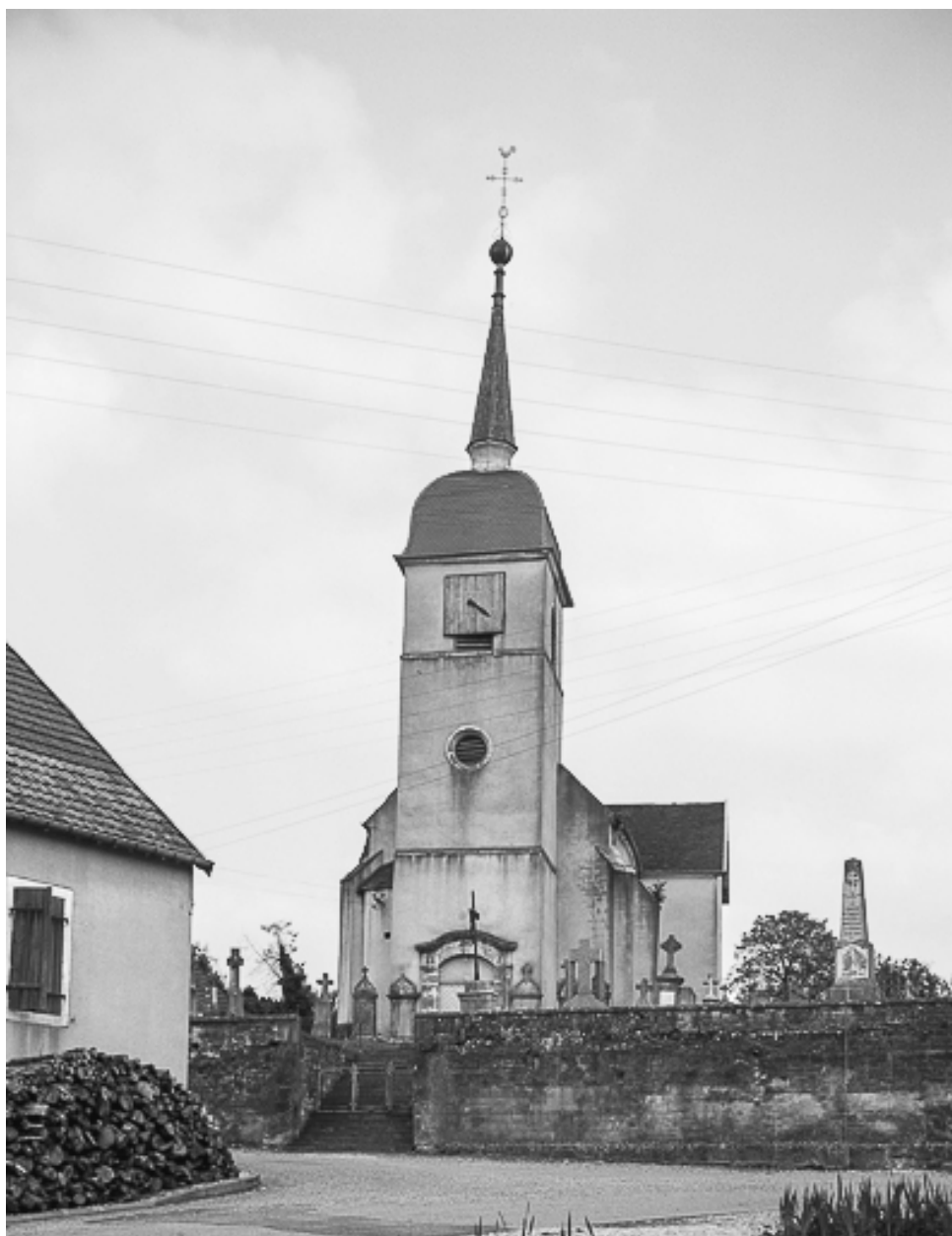
Façade antérieure avec tour-clocher.
