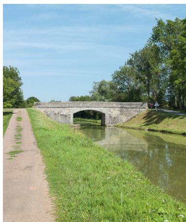
Vue d'ensemble du pont.
