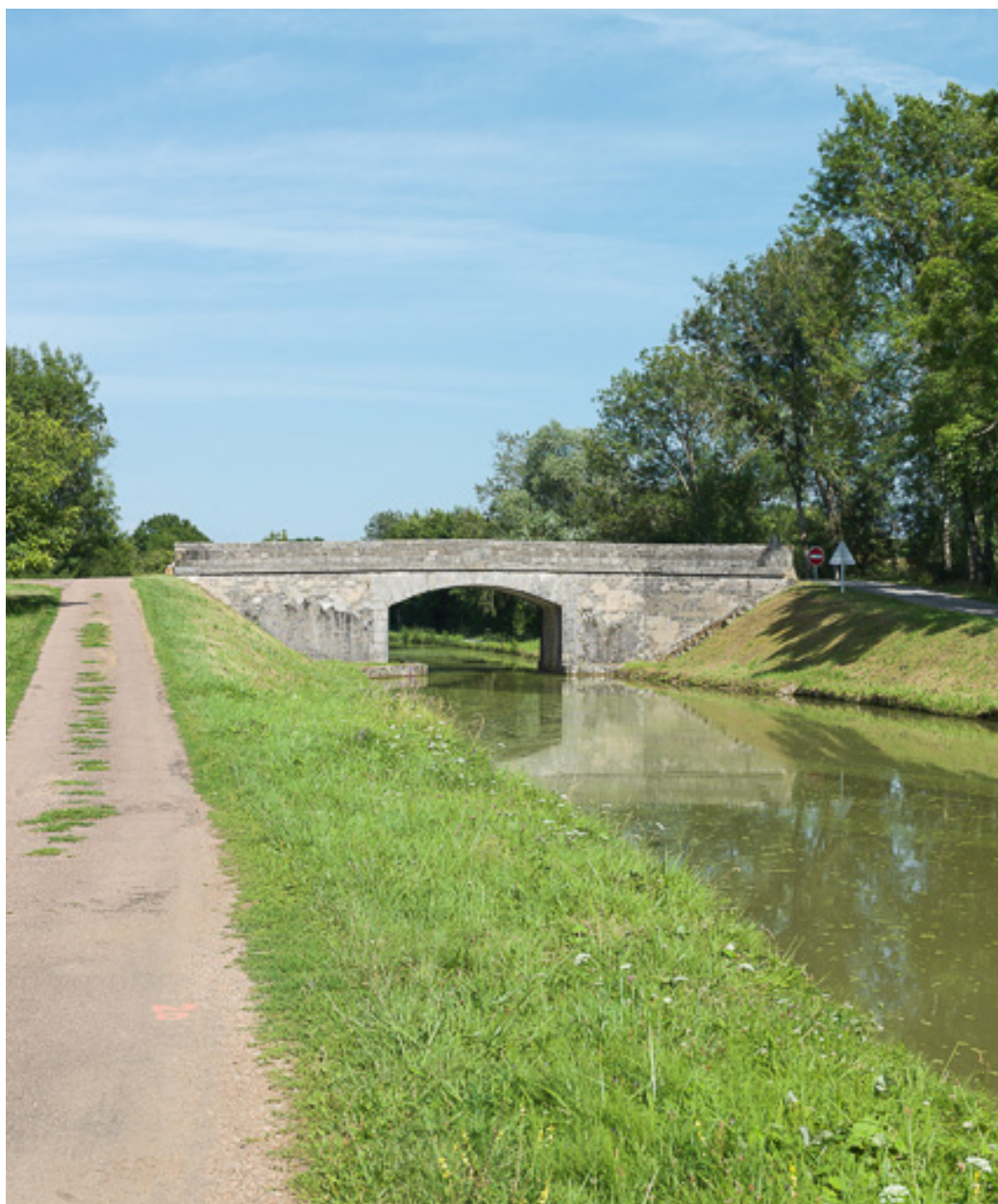
Vue d'ensemble du pont.
