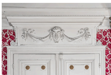
Salle à manger du rez-de-chaussée, portes de la cuisine et du vestibule, détail : masque et draperies en feston. Phot. Pierre-Marie Barbe-Richaud IVR26_20245800108NUC4A
