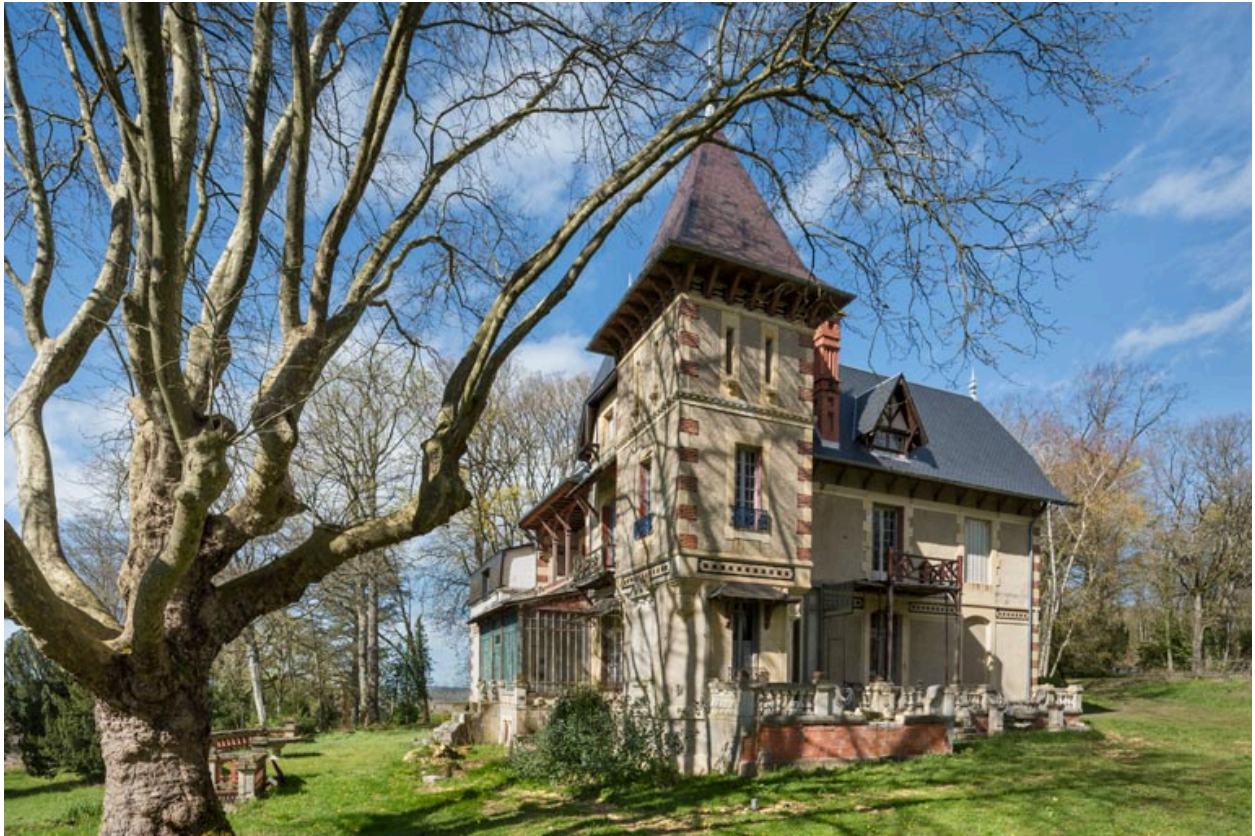
Tour à l'angle des façades ouest et sud.
