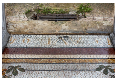
Vestibule du rez-de-chaussée, mosaïque au sol, détail : inscription "19 AVE 04". Phot. Pierre-Marie Barbe-Richaud
