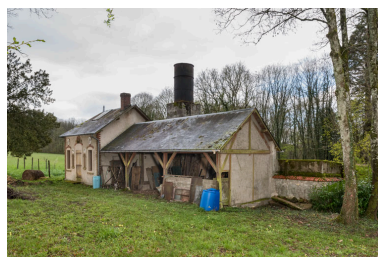
Dépendance dite pavillon de musique. Phot. Pierre-Marie Barbe-Richaud IVR26_20245800117NUC4A
