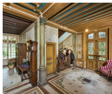
Vestibule au rez-de-chaussée, avec les portes des entrées sud (à droite) et est (à gauche). Phot. Pierre-Marie Barbe-Richaud IVR26_20245800208NUC4A
