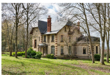
Façades est et nord. Phot. Pierre-Marie Barbe-Richaud IVR26_20245800179NUC4A
