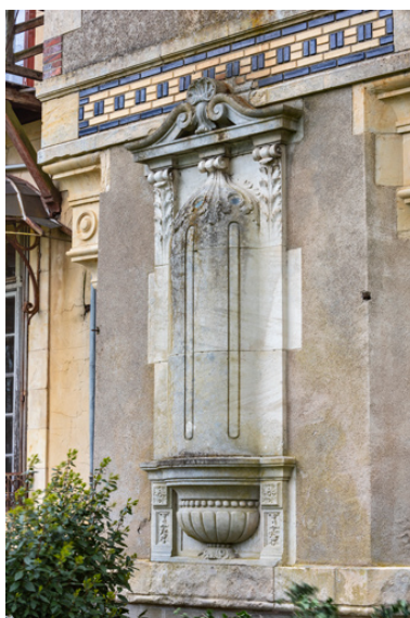
Tour à l'angle des façades ouest et sud, détail : ressaut correspondant à une niche intérieure remplaçant une baie. Phot. Pierre-Marie Barbe-Richaud IVR26_20245800183NUC4A
