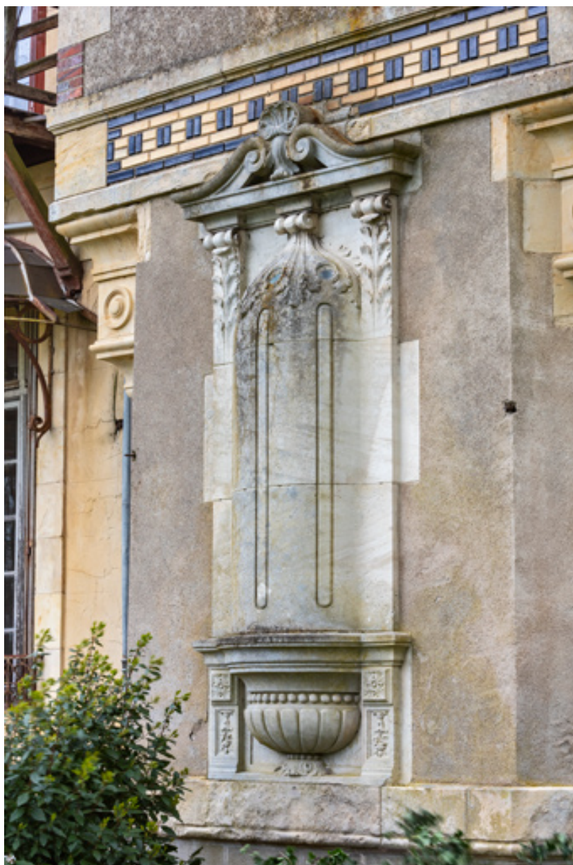
Tour à l'angle des façades ouest et sud, détail : ressaut correspondant à une niche intérieure remplaçant une baie.
