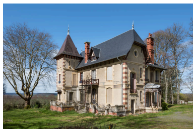
Façades sud et est. Phot. Pierre-Marie Barbe-Richaud IVR26_20245800174NUC4A
