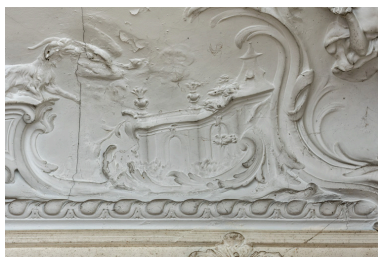
Salon du rez-de-chaussée, plafond, décor sculpté, détail : édifice. Phot. Pierre-Marie Barbe-Richaud IVR26_20245800095NUC4A
