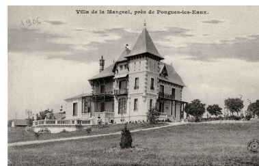
Façades ouest et sud. Autr. auteur inconnu IVR26_20245800213NUC4A
