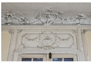
Salon du rez-de- chaussée, dessus-de-porte. Phot. Pierre-Marie Barbe-Richaud IVR26_20245800089NUC4A
