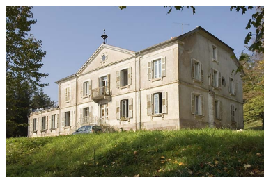
Château dit des Houillères. Phot. Jérôme Mongreville IVR43_20077000609NUCA
