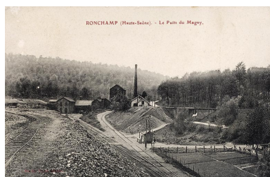
Ronchamp (Haute-Saône). - Le puits du Magny. Phot. Jérôme Mongreville IVR43_20057000644NUCA
