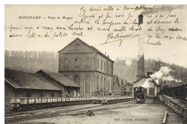
Ronchamp. - Puits du Magny. Phot. Jérôme Mongreville IVR43_20057000642NUCA
