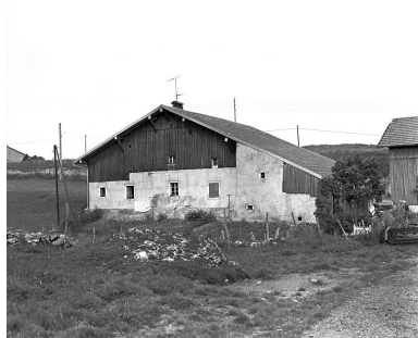
Façade latérale gauche. Phot. Yves Sancey IVR43_19782500395X
