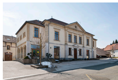
Mairie-fromagerie vue de trois quarts gauche. Phot. Jérôme Mongreville IVR43_20162500232NUC4A
