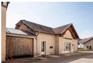
Nouvelle fromagerie vue de trois quarts gauche. Phot. Jérôme Mongreville IVR43_20162500233NUC4A
