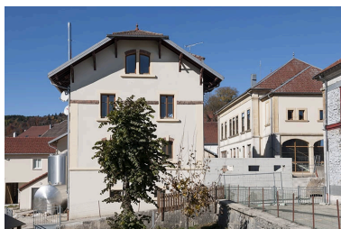
Vue depuis le sud-est. Phot. Jérôme Mongreville IVR43_20152502408NUC4A
